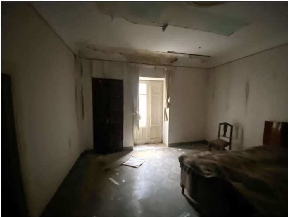
Foto n°12 – P1°- 2 a camera (vista verso il balcone)
