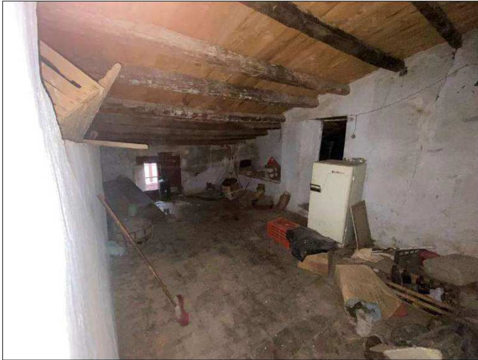
Foto n°13 - P2° - 1^ locale (vista dal vano scala)
