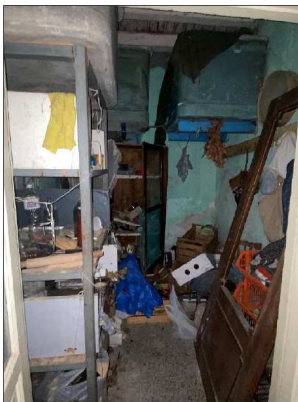
Foto n°6 – PT - Magazzino [N.B.: n°3 serbatoi idrici in fibrocemento-amianto ( eternit )]
