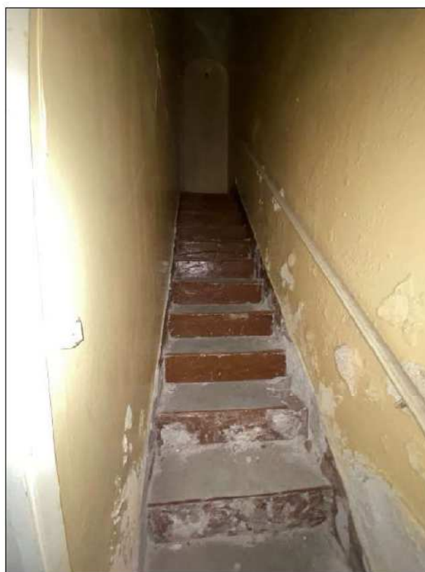
Foto n°8 – Vano scala tra i piani terra e 1°
