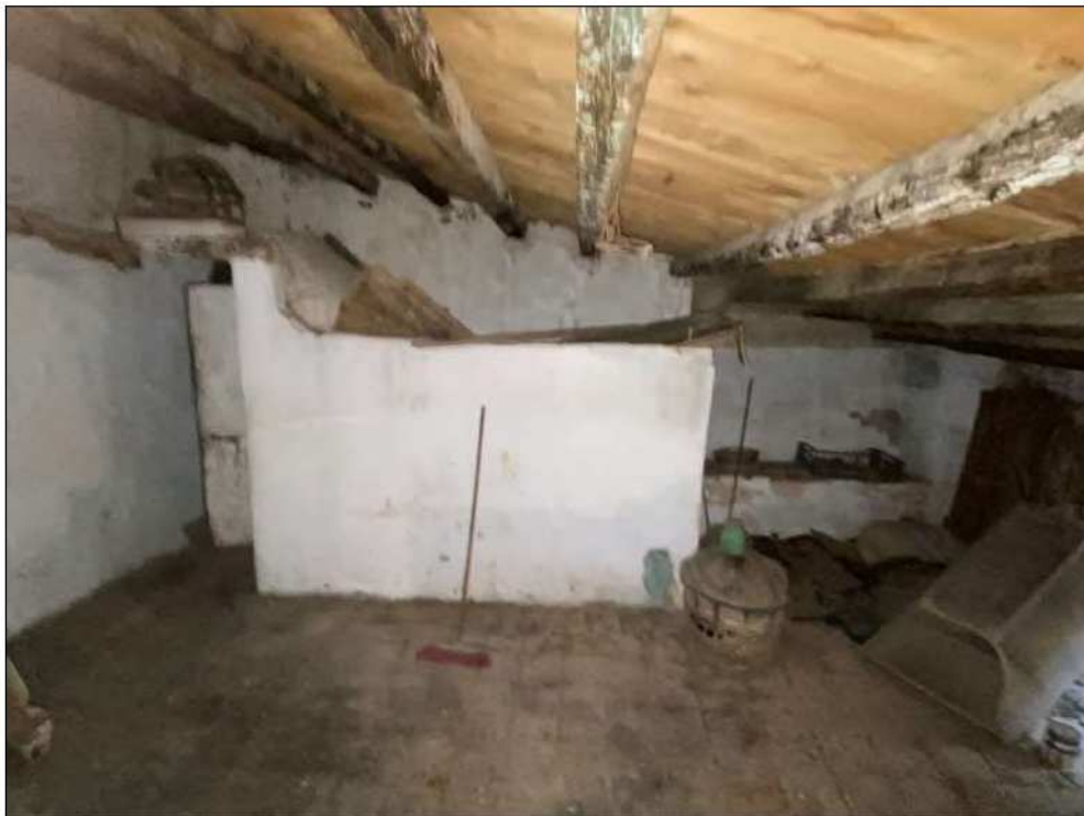
Foto n°14 - P1° - 1^ locale (vista verso il vano scala)
