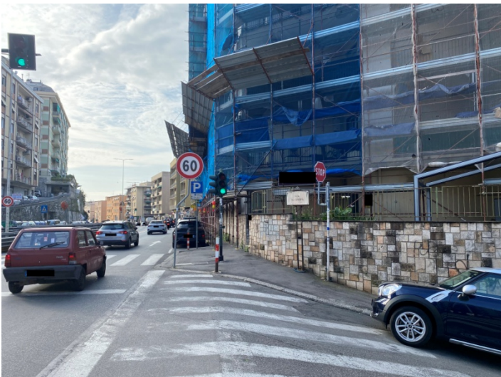
3 vista da incrocio via dell'Ombra-corso Europa
