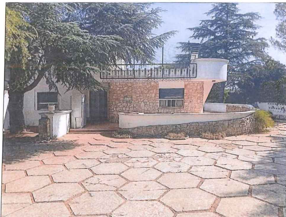
Foto n. 2 - Prospetto principale - zona antistante il compendio immobiliare - Portoncino di accesso agli ambienti di piano terra
