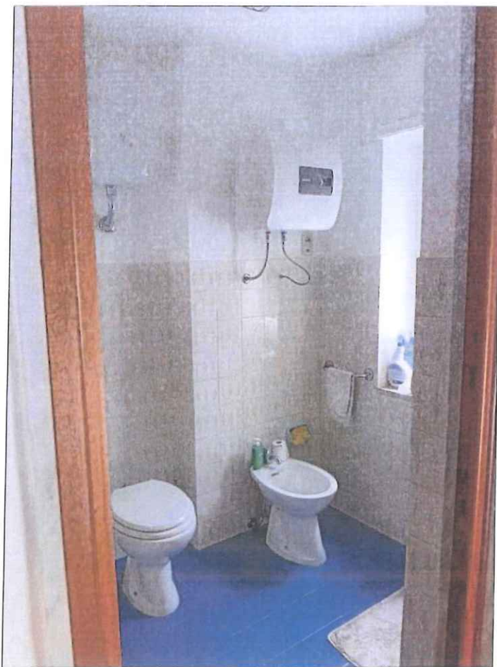
Foto n. 20 - Piano primo - bagno
