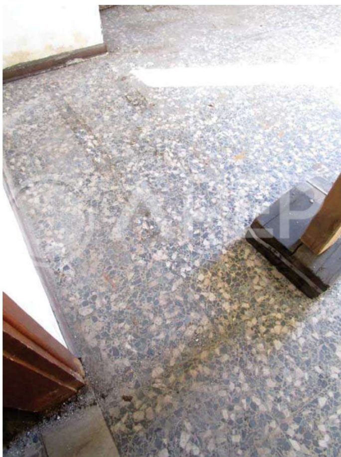
Foto 5 – Vista Lotto 1 parte residenziale – particolare dei pavimenti del piano terra
