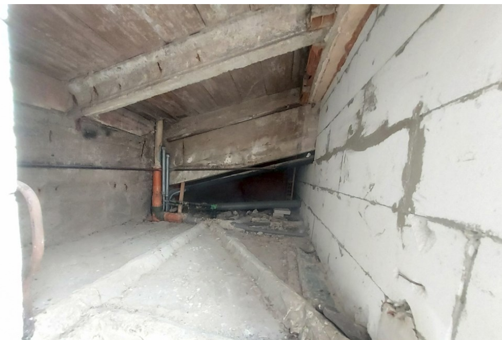
SOTTOTETTO CON ACCESSO DALLA CUCINA/LAVANDERA
