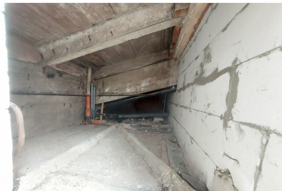
SOTTOTETTO CON ACCESSO DALLA CUCINA/LAVANDERA
