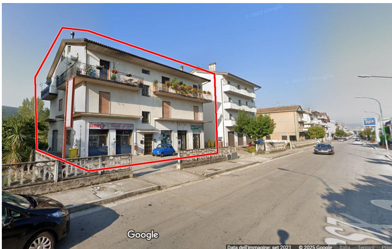
Figura 3. Fabbricato oggetto di indagine, mappale 412. Fonte: Google Maps.
