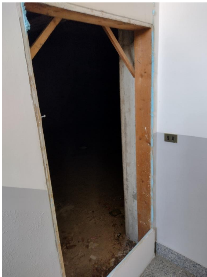
Figura 18. Accesso al piano primo.
