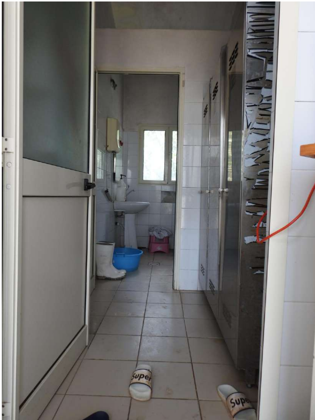
Figura 37 - Fabbricato A, minicaseificio. Foto interna spogliatoio e bagno
