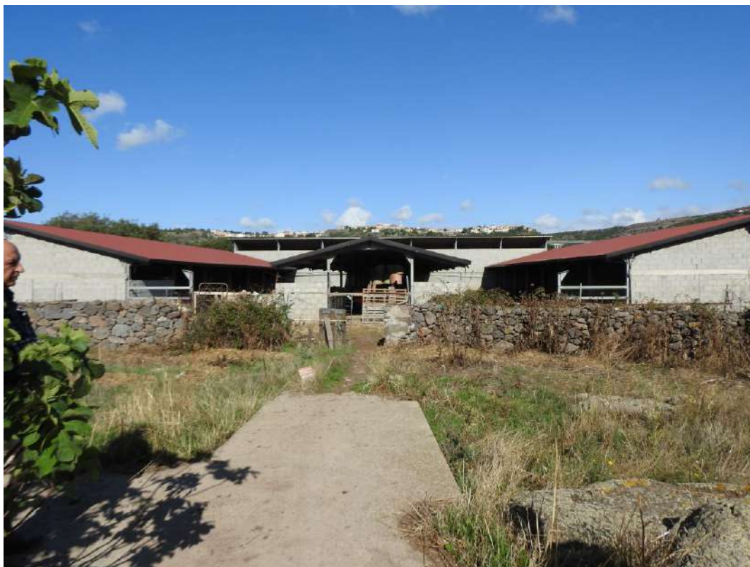
Figura 54 - Fabbricato D, fienile/stalla. Visuale principale
