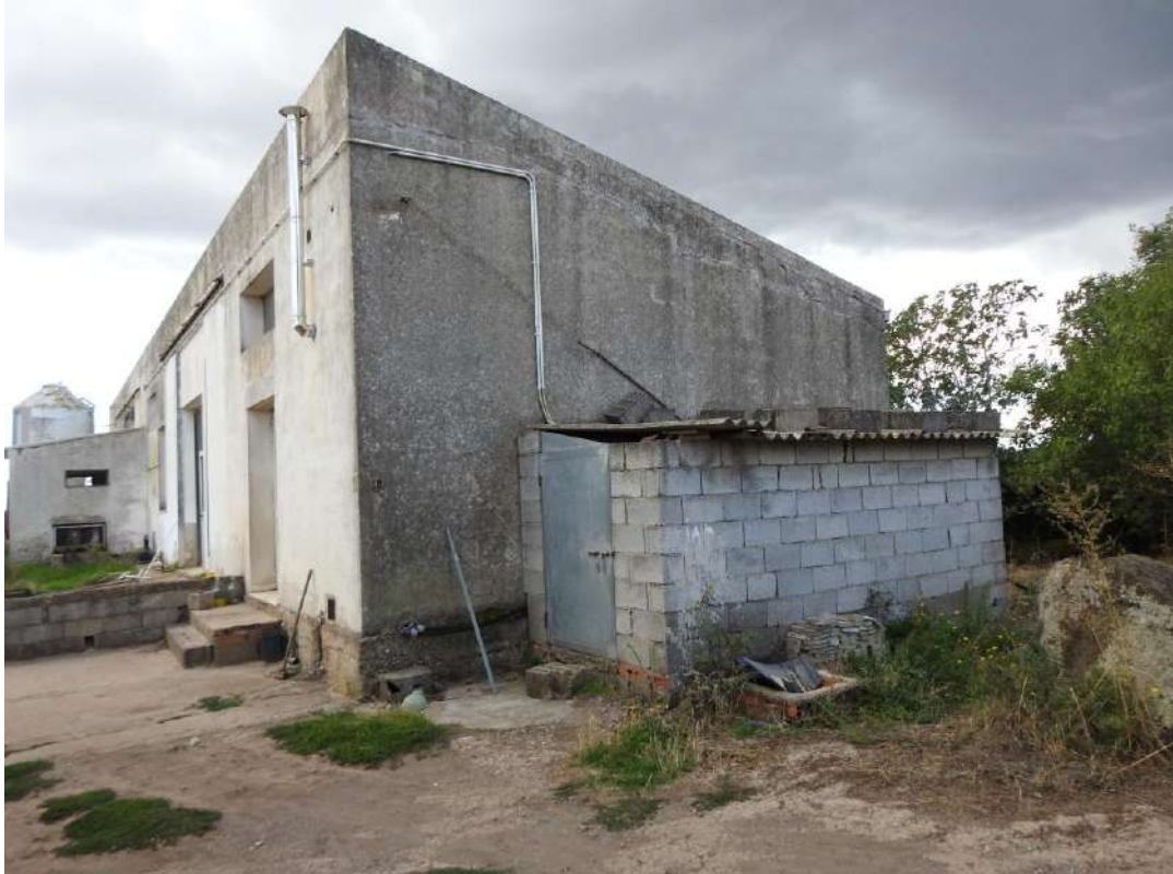
Figura 24 - Fabbricato A, minicaseificio. Vista laterale su volume abusivo
