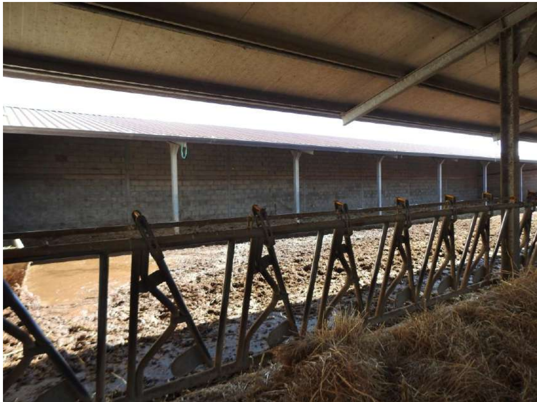
Figura 59 – Fabbricato D, fienile/stalla. Visuale interna
