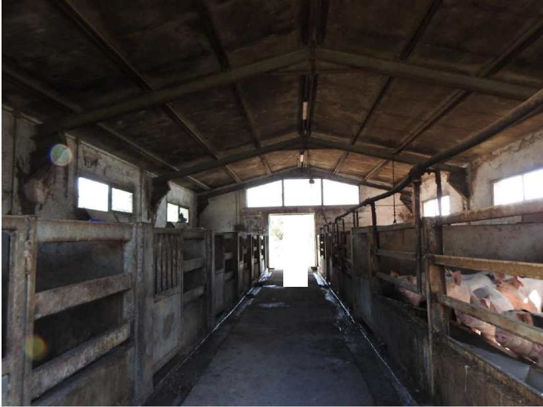
Figura 64- Fabbricato F. Porcilaia
