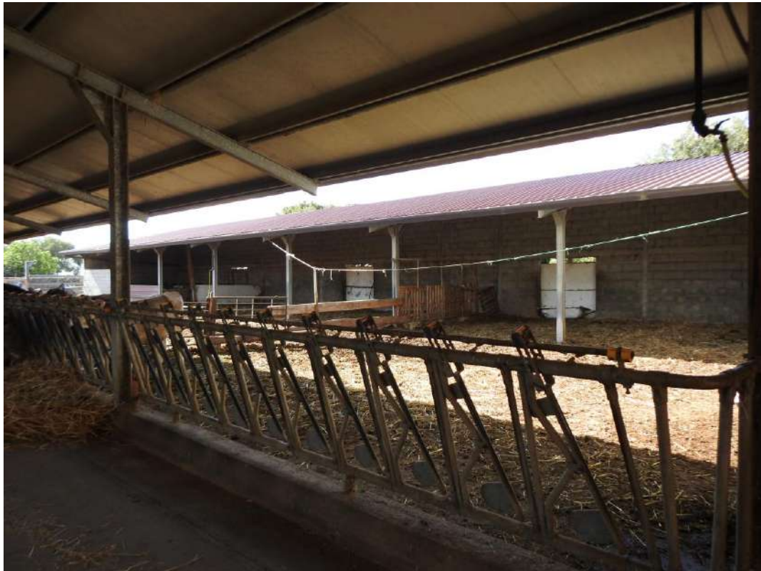
Figura 58 – Fabbricato D, fienile/stalla. Visuale interna
