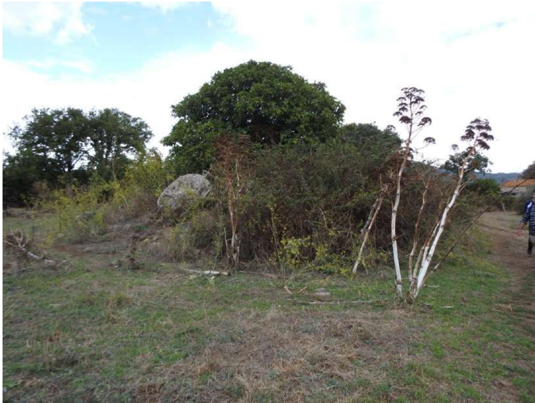
Figura 19 - Fabbricato E. Casa rurale distrutta
