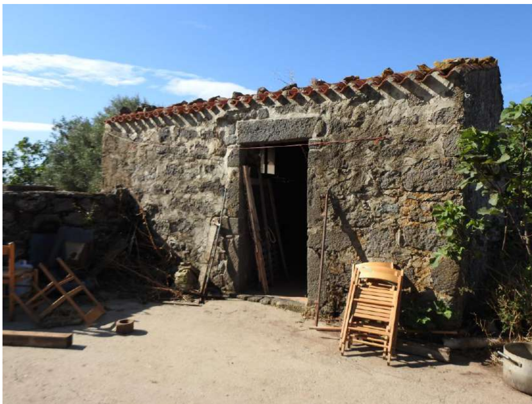
Figura 50 – Casa rurale, prospetto principale
