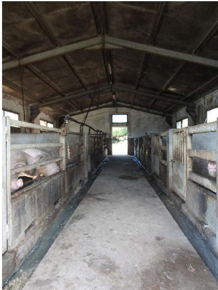
Figura 65 – Fabbricato F. Porcilaia
