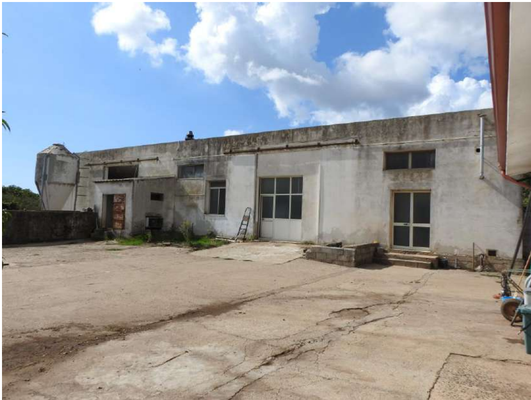
Figura 23 - Fabbricato A, minicaseificio. Vista frontale
