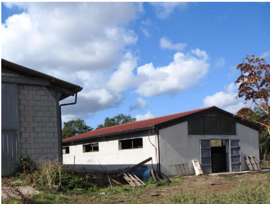
Figura 63- Fabbricato F. Porcilaia
