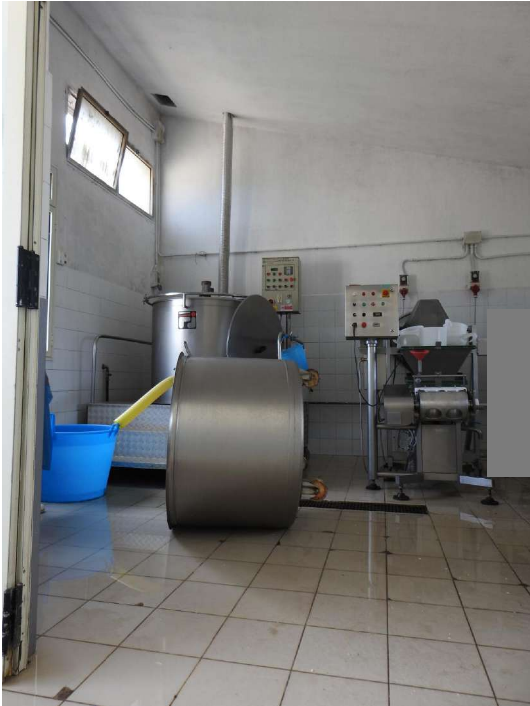
Figura 28 - Fabbricato A, minicaseificio. Foto interna sala lavorazione
