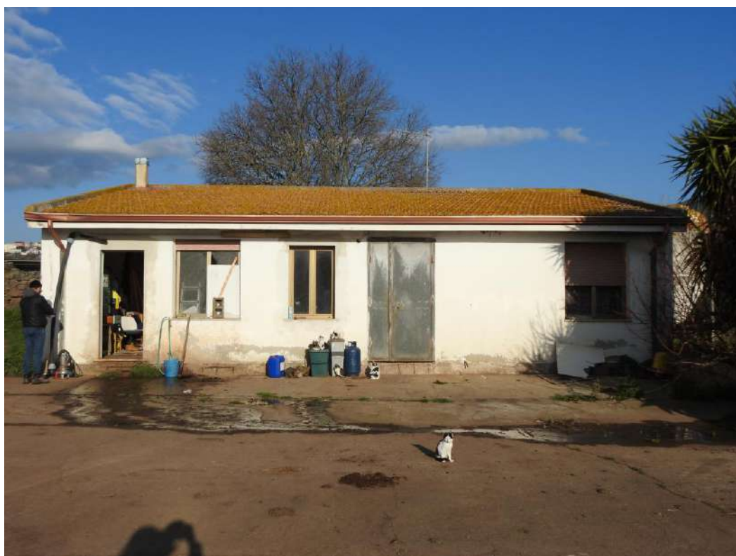
Figura 40 – Casa colonica, prospetto principale
