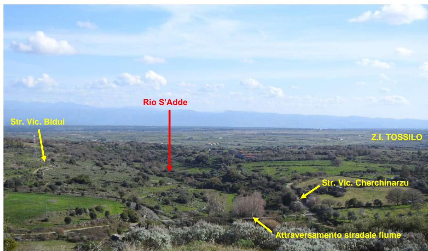
Figura 9 - Visuale dei luoghi dal viadotto sul Rio S'Adde
