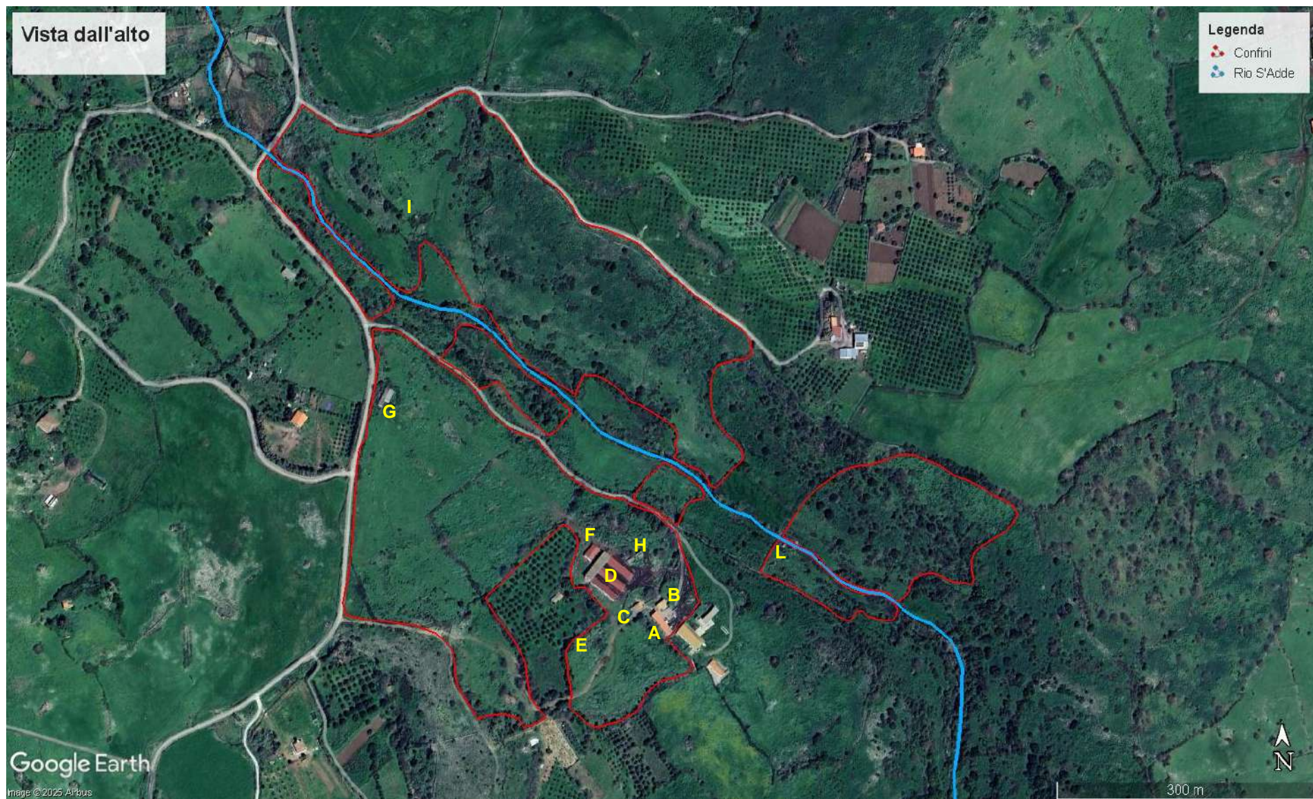
Figura 12 - Ortofoto con perimetrazione dei luoghi pignorati con sommaria indicazione dell'ubicazione dei fabbricati
