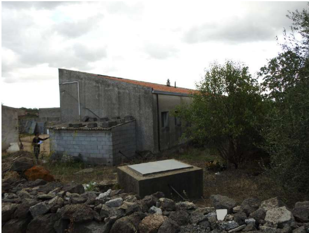
Figura 25 - Fabbricato A, minicaseificio. Vista del prospetto secondario
