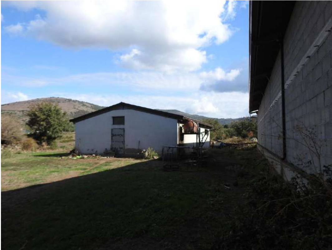
Figura 62 - Fabbricato F. Porcilaia
