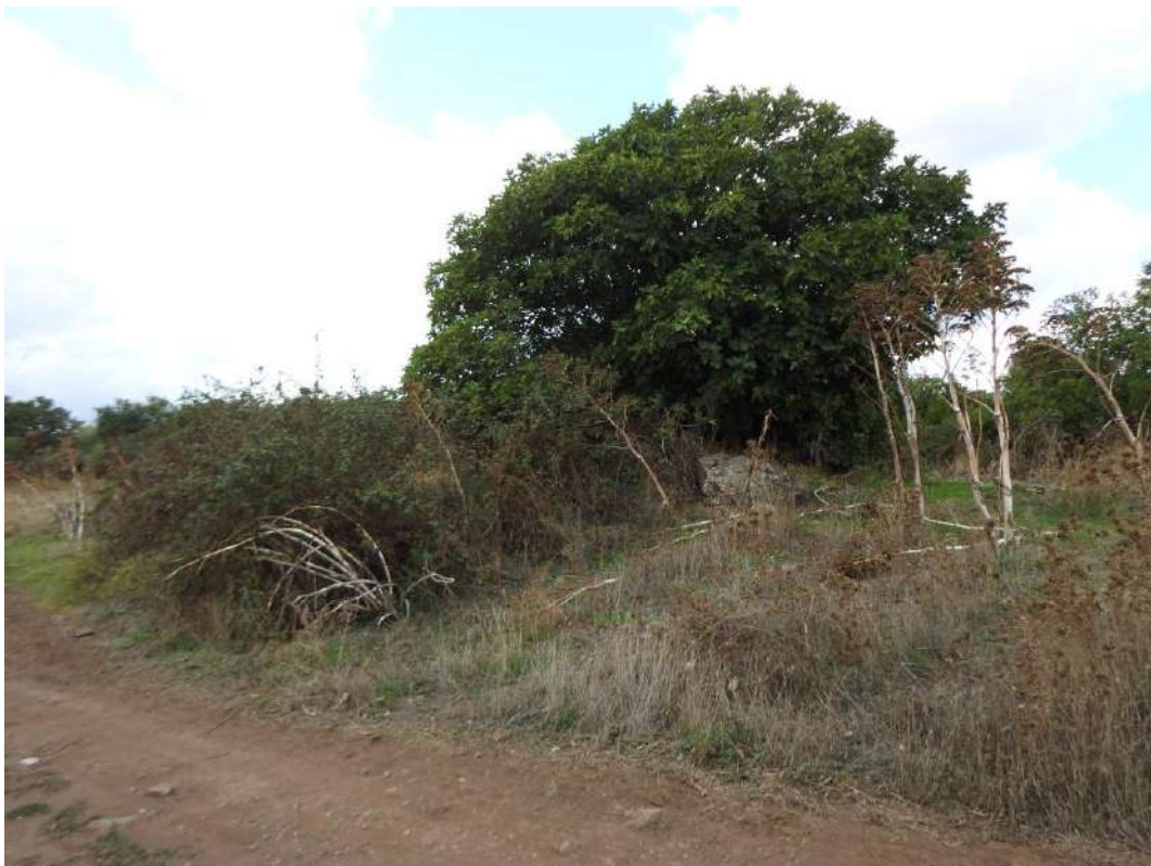
Figura 20 - Fabbricato E. Casa rurale distrutta
