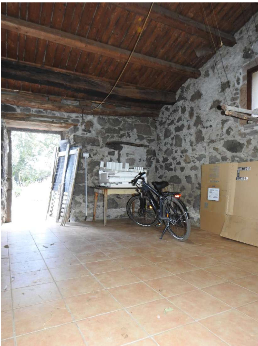
Figura 53 – Casa rurale, visuale interna
