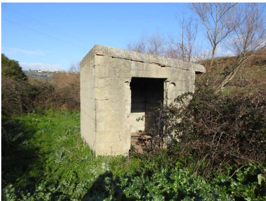
Figura 22 – Fabbricato L, ricovero edificato in adiacenza al Rio S'Adde
