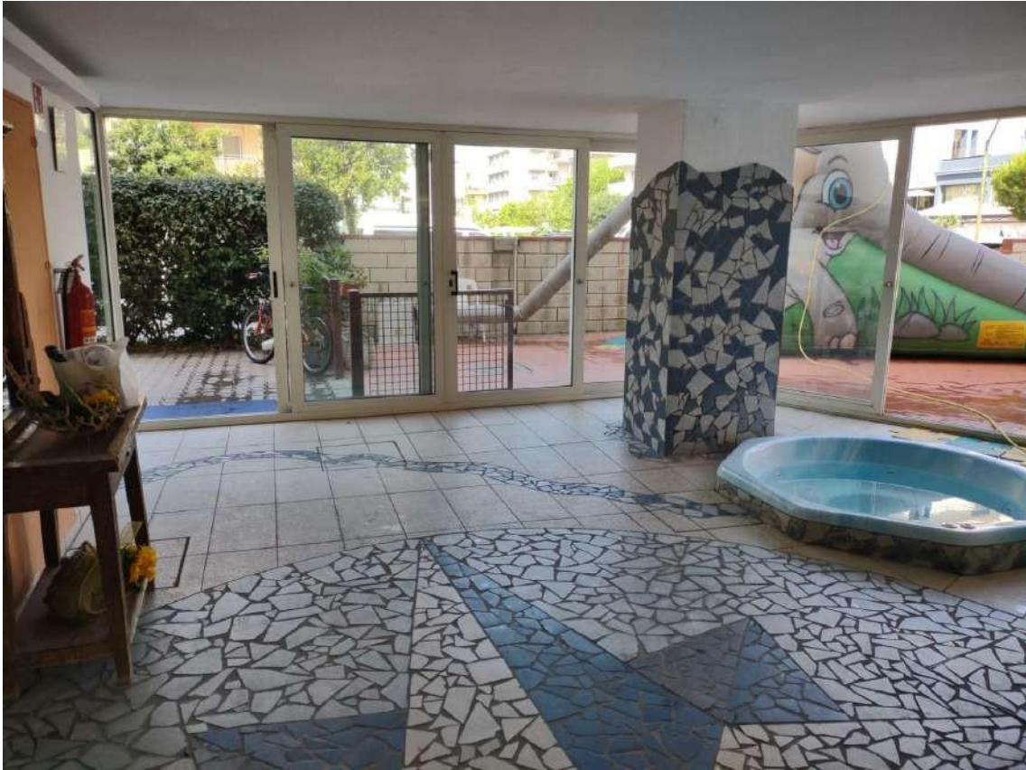
FOTO 12. Piano Terra: porticato vetrato - vista sulla piscina
