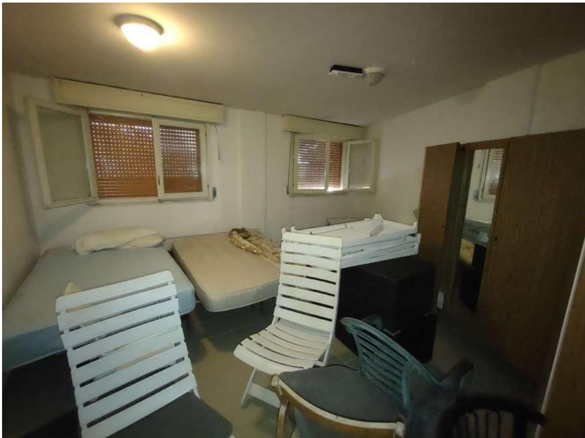
FOTO 19. Piano Terra: vano ad uso ripostiglio nella zona servizi
