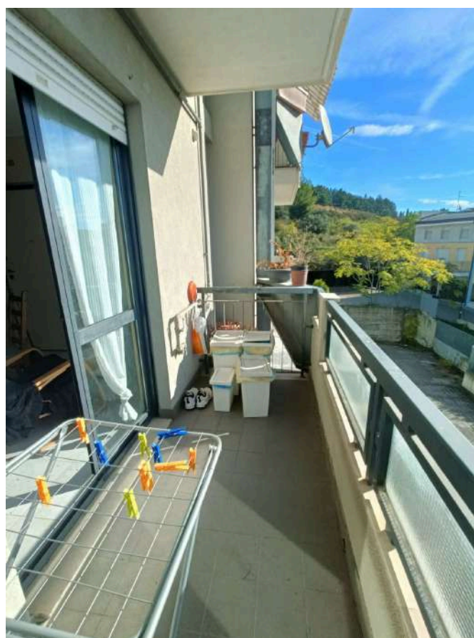
Stazione dei Carabinieri di Pescara Colli sita in Pescara al Largo Padre Alberto Mileno n.34, ai piani interrato, terra, primo, secondo, terzo e quarto, distinta al Catasto Fabbricati al Foglio n.11 Particella n.1935 Sub. n.106. PIANO SECONDO – LATO OVEST
