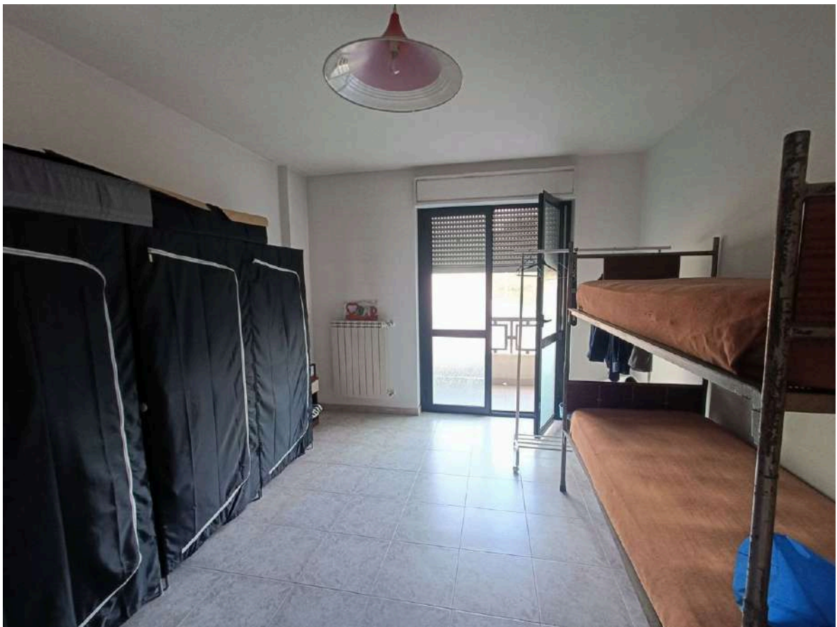
Stazione dei Carabinieri di Pescara Colli sita in Pescara al Largo Padre Alberto Mileno n.34, ai piani interrato, terra, primo, secondo, terzo e quarto, distinta al Catasto Fabbricati al Foglio n.11 Particella n.1935 Sub. n.106. PIANO SECONDO – LATO EST
