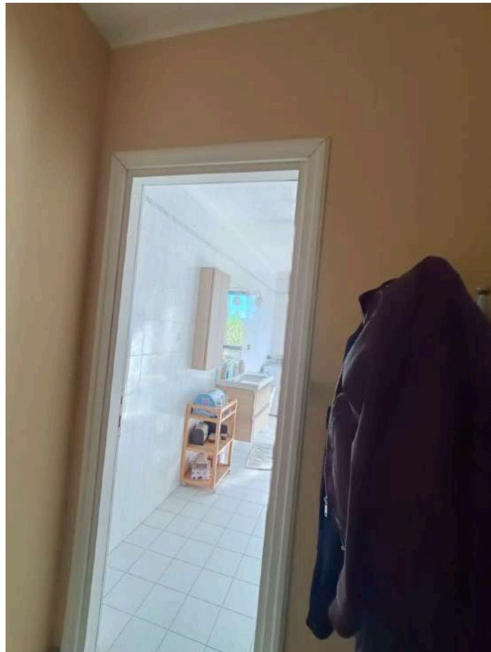
Stazione dei Carabinieri di Pescara Colli sita in Pescara al Largo Padre Alberto Mileno n.34, ai piani interrato, terra, primo, secondo, terzo e quarto, distinta al Catasto Fabbricati al Foglio n.11 Particella n.1935 Sub. n.106. PIANO SECONDO – LATO OVEST
