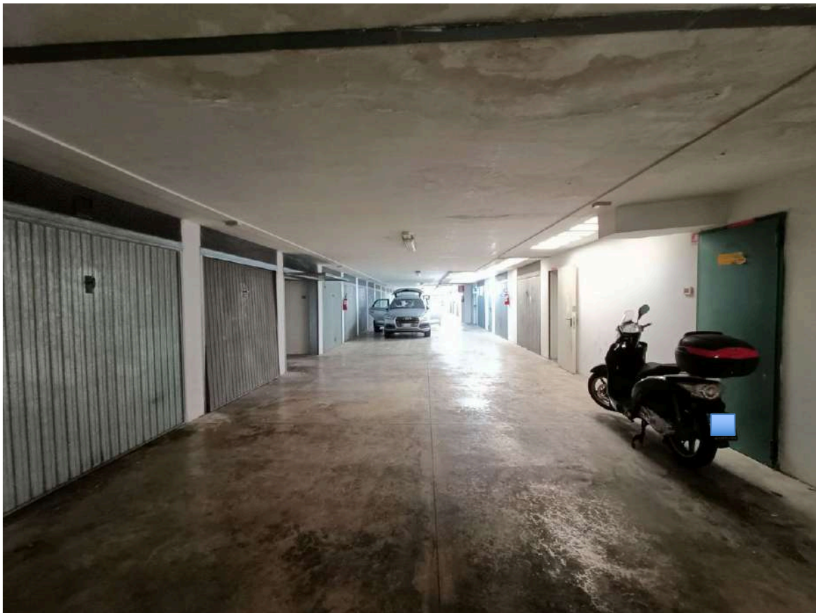
Stazione dei Carabinieri di Pescara Colli sita in Pescara al Largo Padre Alberto Mileno n.34, ai piani interrato, terra, primo, secondo, terzo e quarto, distinta al Catasto Fabbricati al Foglio n.11 Particella n.1935 Sub. n.106. PIANO INTERRATO – LATO OVEST
