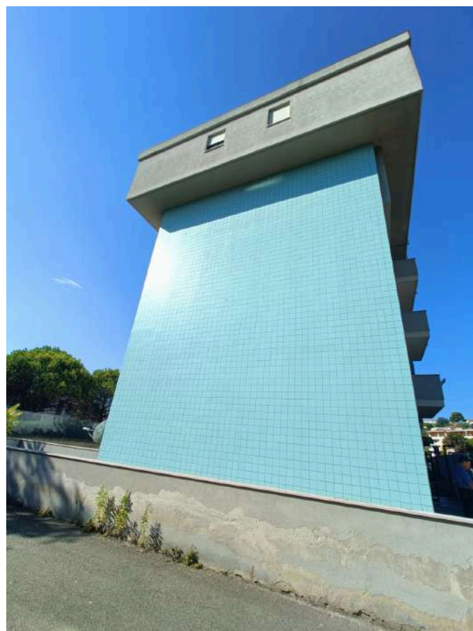
Fabbricato sito in Pescara al Largo Padre Alberto Mileno/Via di Sotto insistente su terreno distinto al Catasto Terreni al Foglio n.11 Particella n.1935. ESTERNI
