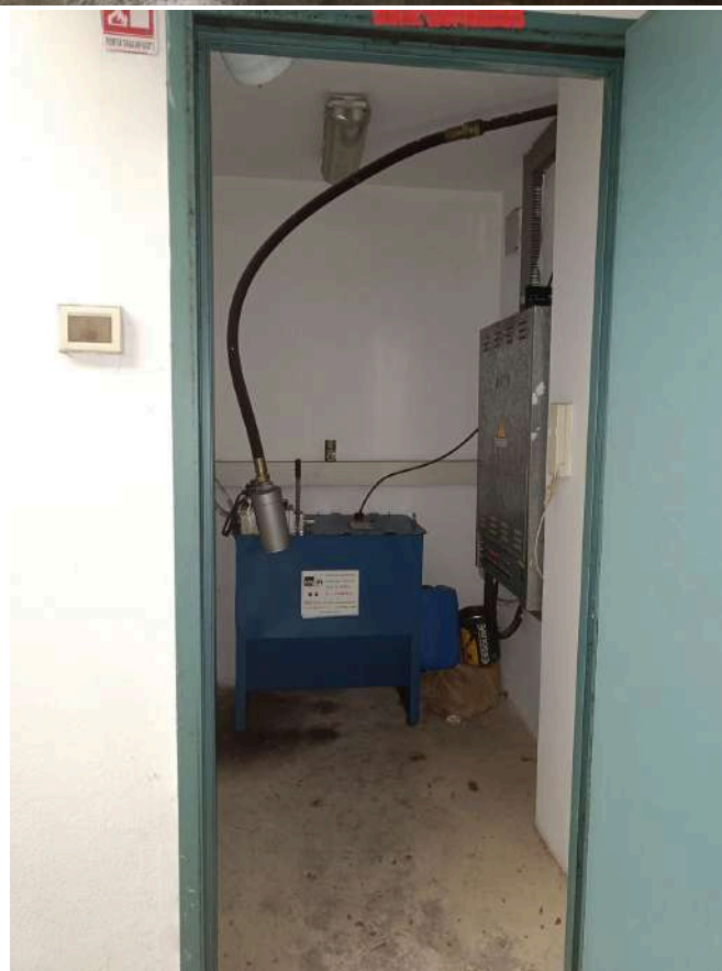
Stazione dei Carabinieri di Pescara Colli sita in Pescara al Largo Padre Alberto Mileno n.34, ai piani interrato, terra, primo, secondo, terzo e quarto, distinta al Catasto Fabbricati al Foglio n.11 Particella n.1935 Sub. n.106. PIANO INTERRATO – LATO OVEST
