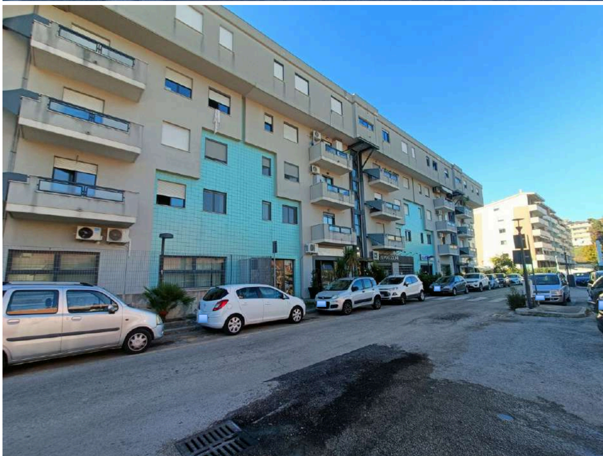
Fabbricato sito in Pescara al Largo Padre Alberto Mileno/Via di Sotto insistente su terreno distinto al Catasto Terreni al Foglio n.11 Particella n.1935. ESTERNI
