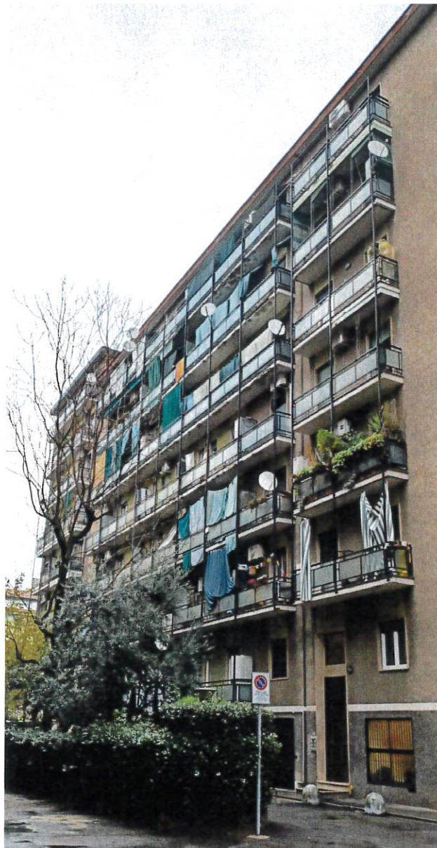
LOTTO 1 >>>abitazione + solaio
