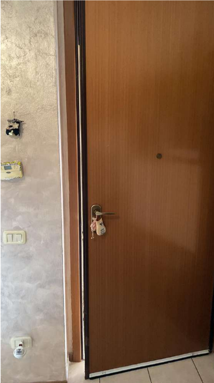
Foto 16 – particolare porta blindata d'ingresso
