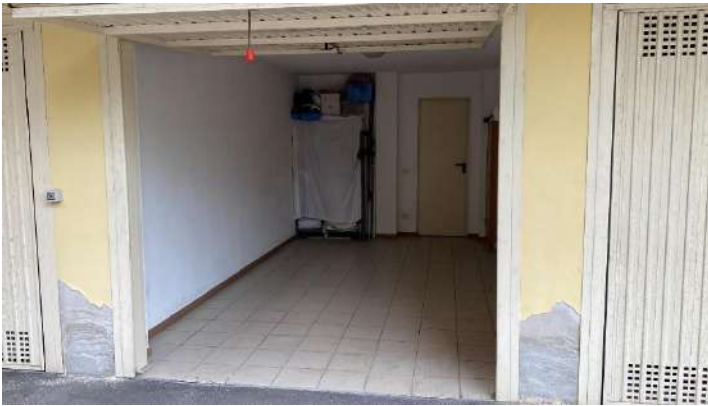
Foto 11 – garage visto da rampa condominiale
