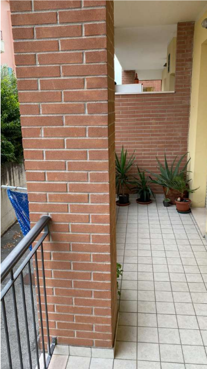
Foto 12 – balcone su retro del fabbricato con pavimentazione in klinker
