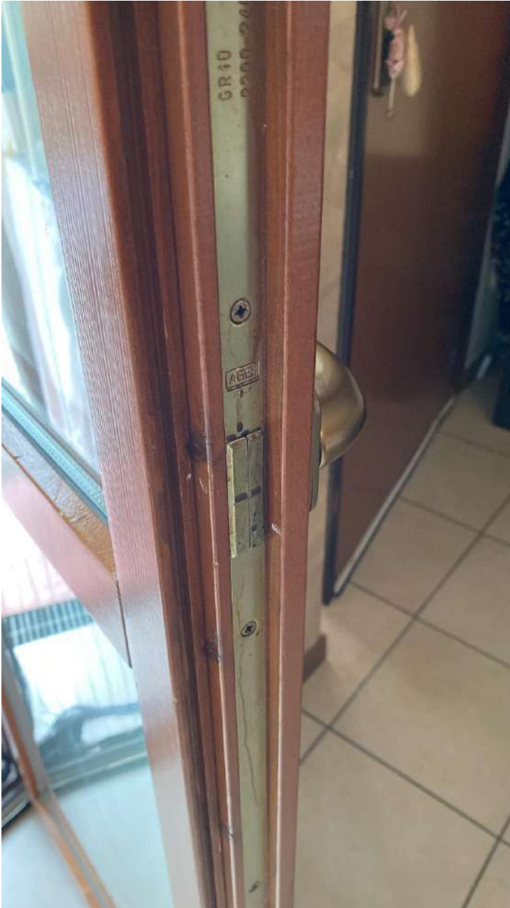
Foto 18 – particolare infisso esterno
