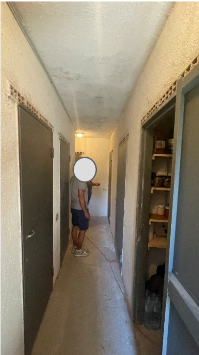
2 Corridoio di distribuzione
