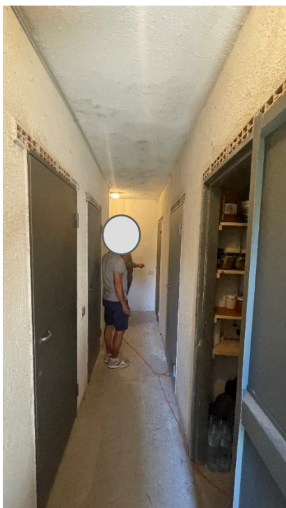
2 Corridoio di distribuzione
