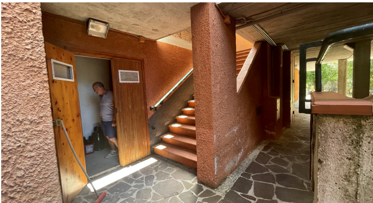
1 Accesso esterno alle cantine, Piano 0
