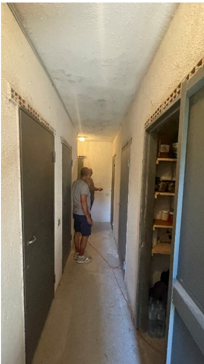
2 Corridoio di distribuzione
