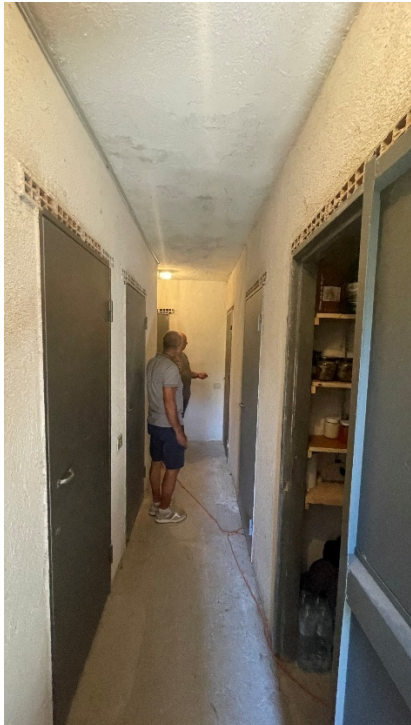
2 Corridoio di distribuzione
