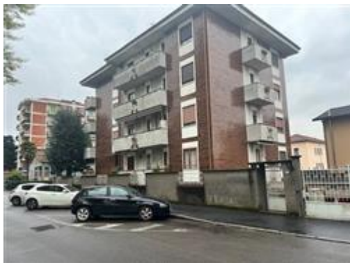
vista esterna condominio
