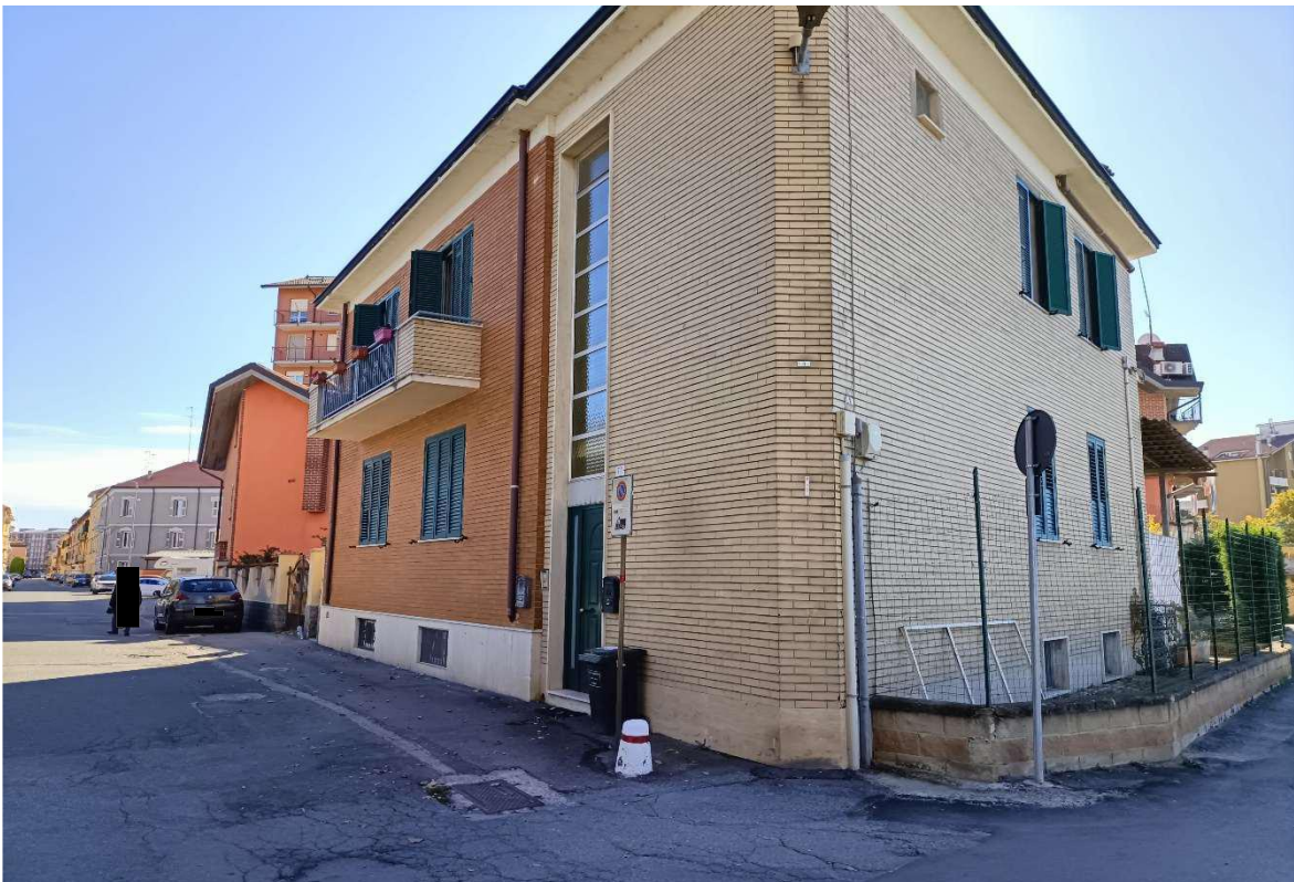
Alloggio piano rialzato. Esterni su via Scazzola foto 1-2)
