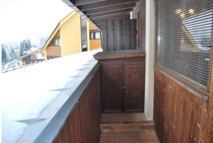
Poggiolo-terrazza lato est
