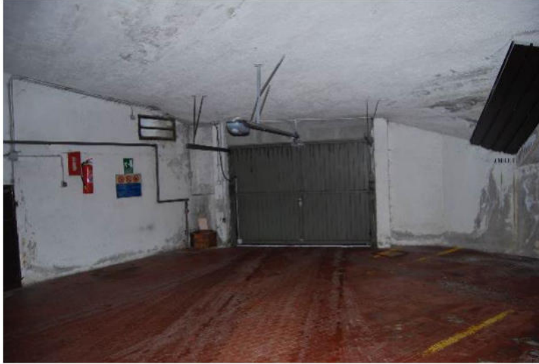
PORTA D'INGRESSO GARAGE COMUNE
