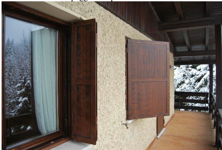
Serramenti esterni – poggio coperto
