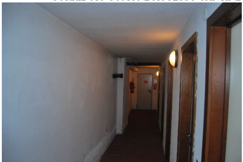
CORRIDOIO COMUNE ACCESSO CANTINE
