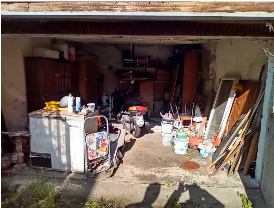
Foto 18: Rustico, porzione del fabbricato ad un piano – vano interno
