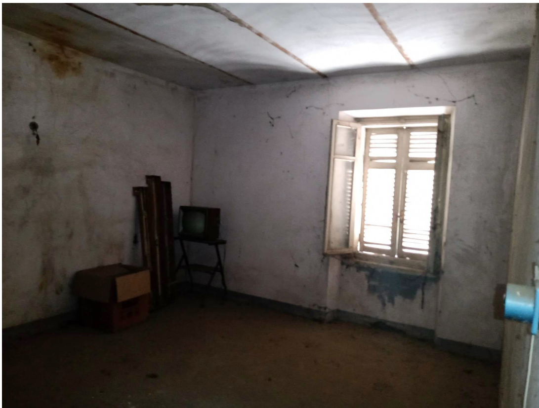
Foto 25: Rustico, vano al piano primo #1
