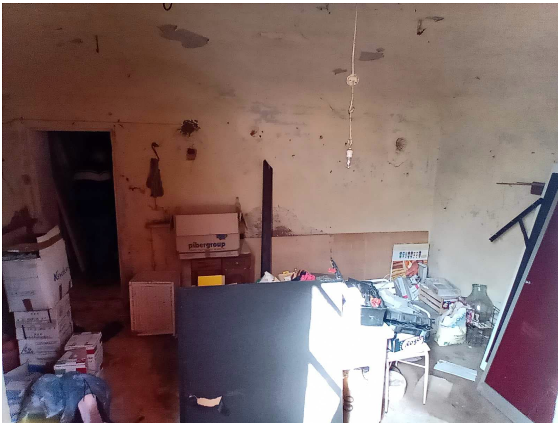
Foto 20: Rustico, vano al piano terreno (ribassato) #1
