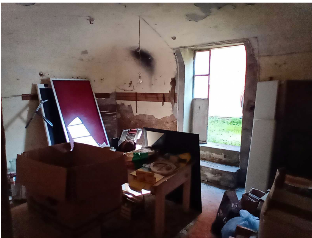
Foto 21: Rustico, vano al piano terreno (ribassato) #2
