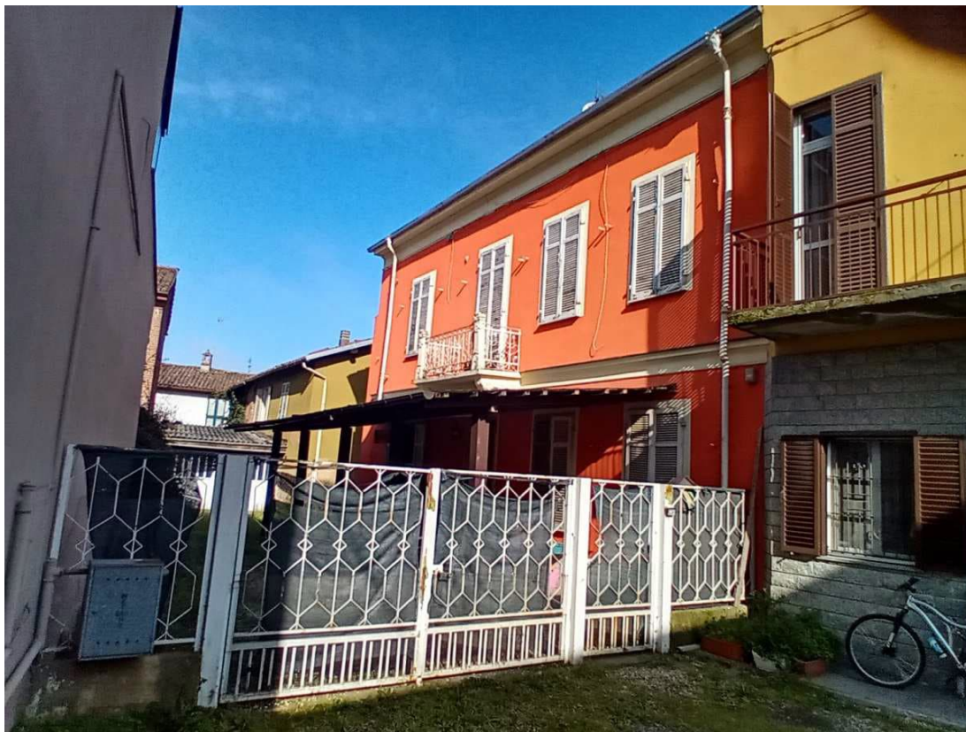
Foto 1: Casa di abitazione, prospetto SUD
