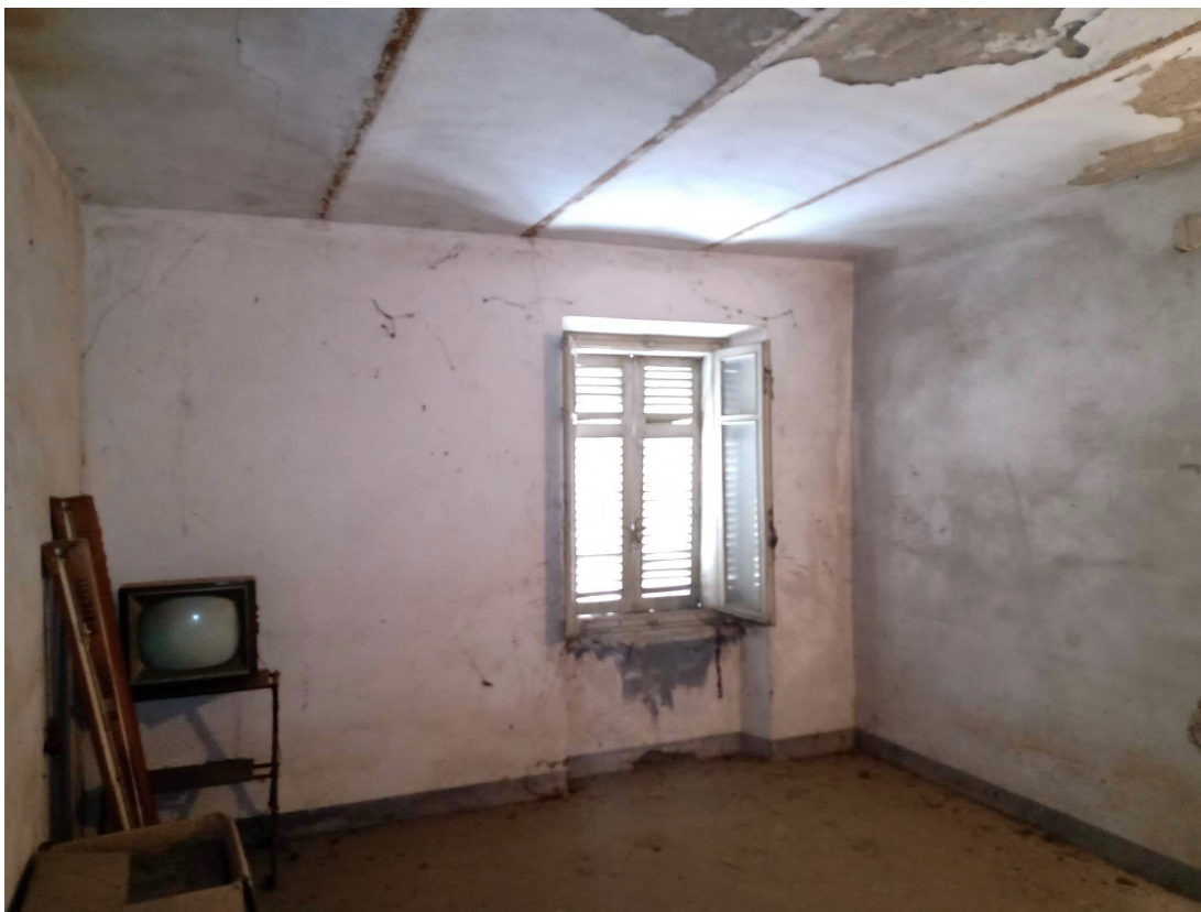
Foto 26: Rustico, vano al piano primo #2
