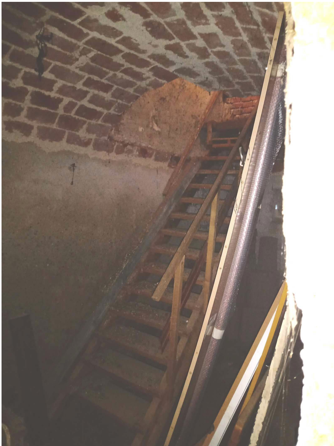
Foto 22: Rustico, scala interna in legno
