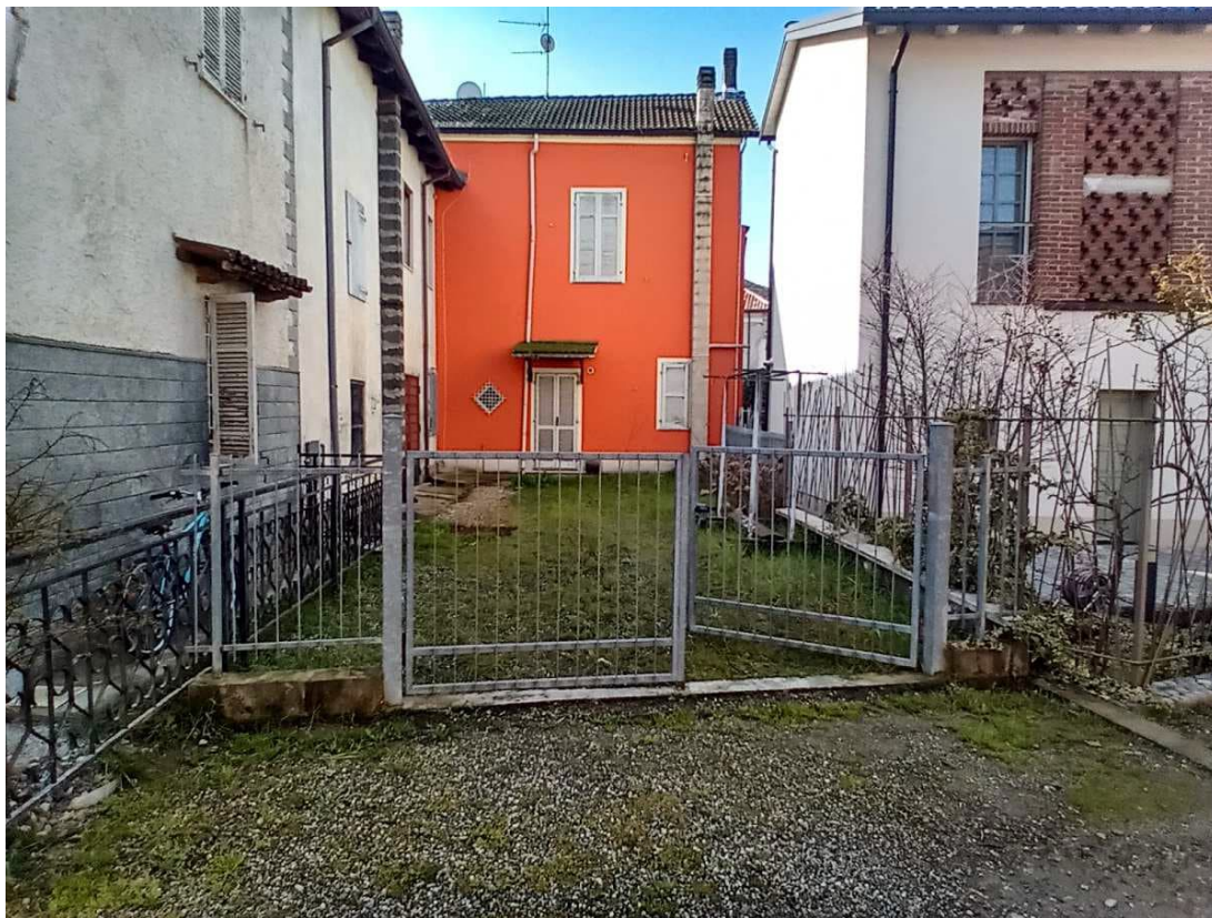
Foto 3: Casa di abitazione, prospetto NORD
