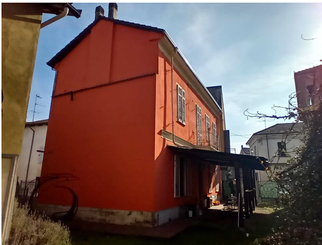
Foto 2: Casa di abitazione, prospetto OVEST
