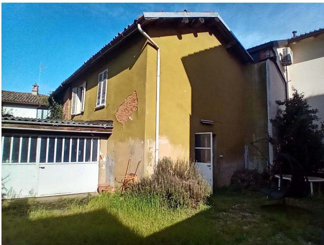
Foto 19: Rustico, porzione del fabbricato a 2 piani, lato EST
