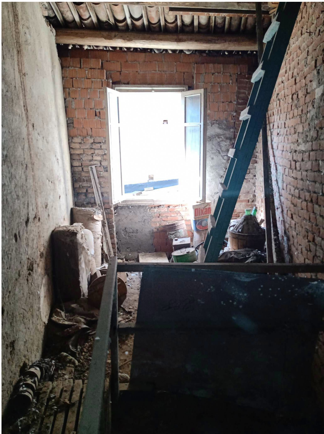
Foto 24: Rustico, pianerottolo e disimpegno a piano primo
