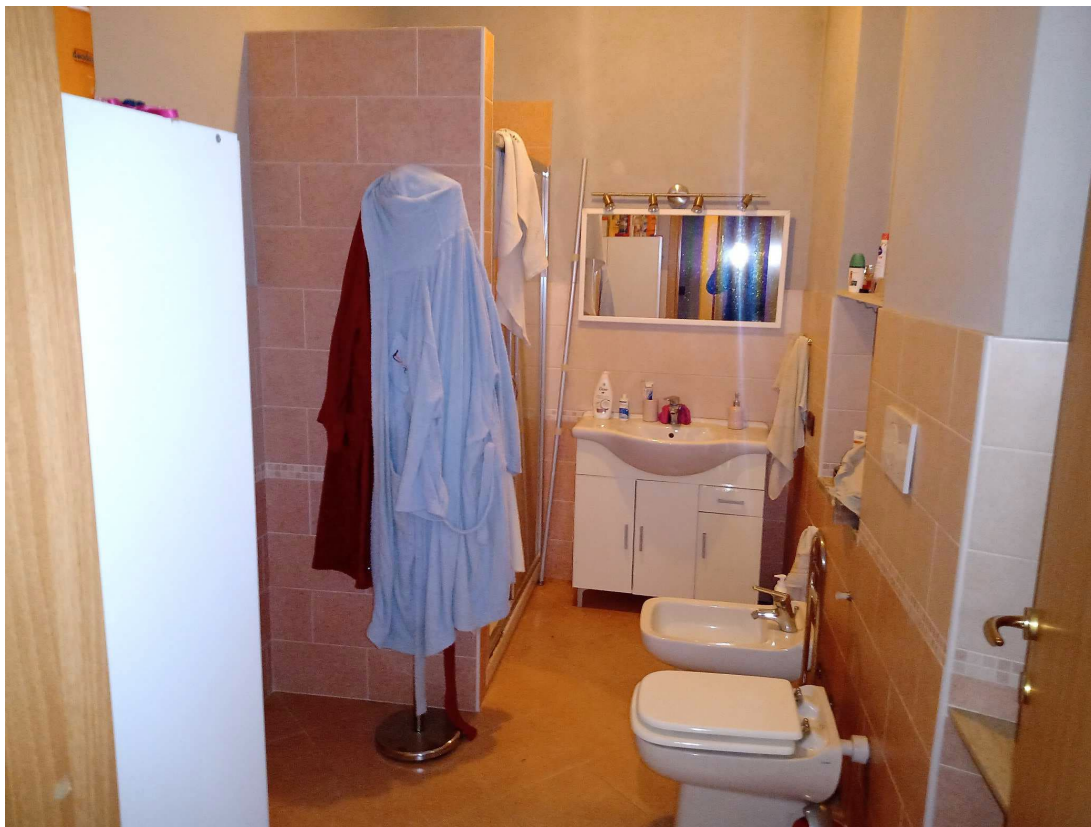
Foto 16: Casa di abitazione, servizio igienico al primo piano
