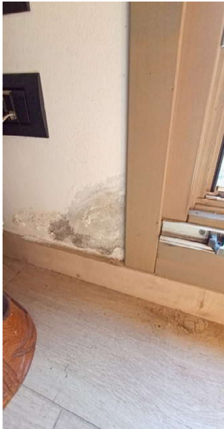
Immagine 10 - Infiltrazione sulla parete del soggiorno in corrispondenza del terrazzo a pozzo - Fonte: Sopralluogo in loco
