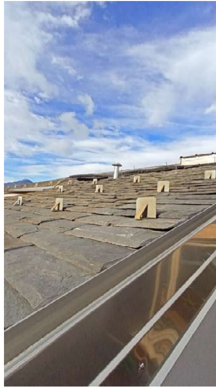
Immagine 12 - Particolare lattoneria in copertura - Fonte: Sopralluogo in loco
