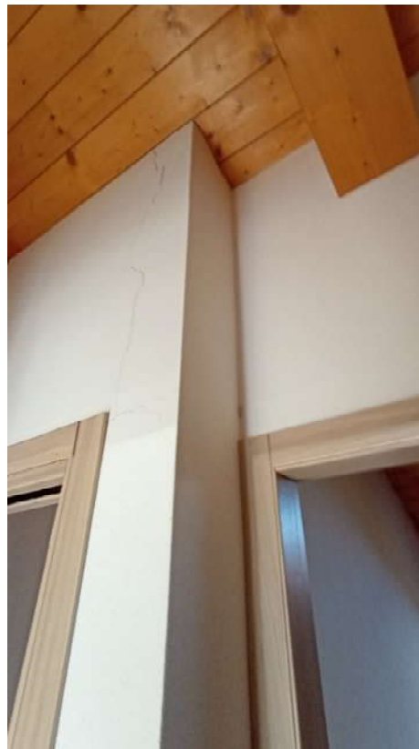
Immagine 18 - Fessure in corrispondenza delle tramezzature nel disimpegno notte - Fonte: Sopralluogo in loco
