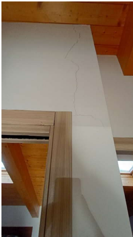
Immagine 18 - Fessure in corrispondenza delle tramezzature nel disimpegno notte - Fonte: Sopralluogo in loco
