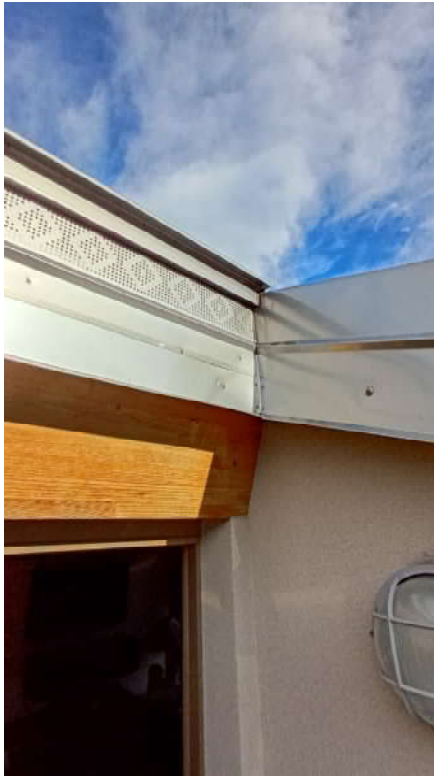
Immagine 12 - Particolare lattoneria in copertura - Fonte: Sopralluogo in loco
