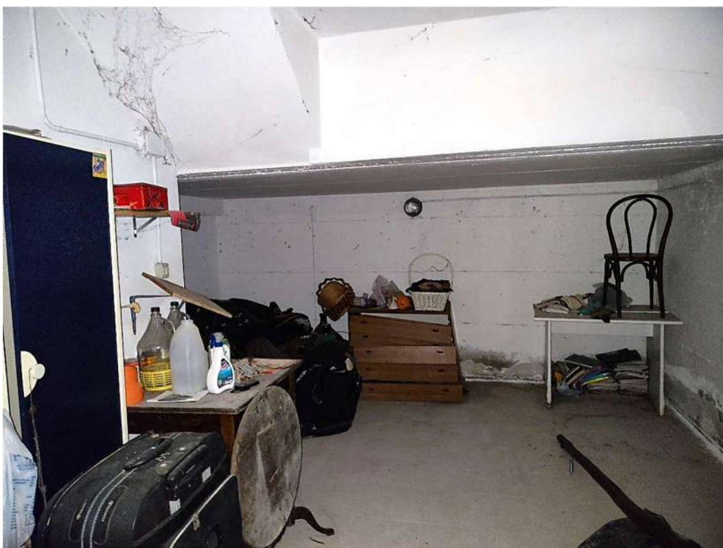
Foto 36 - Parte terminale del box auto con altezza ribassata (180 cm)
