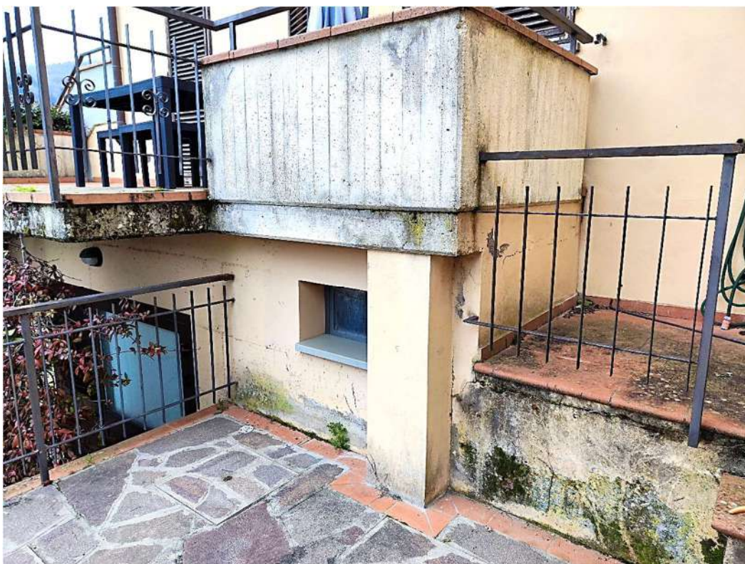
Foto 11 - Particolare delle terrazze del resede lato Via Salvador Allende
