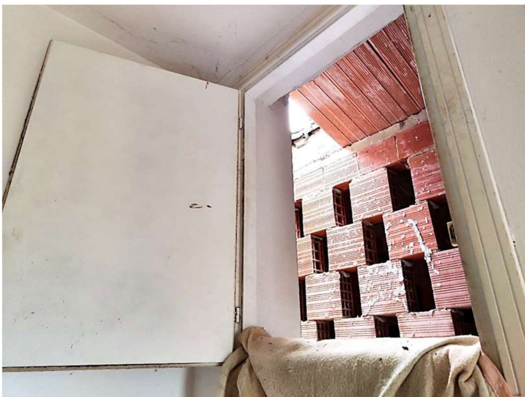
Foto 29 - Botola di accesso al sottotetto (presumibilmente di altra proprietà)
