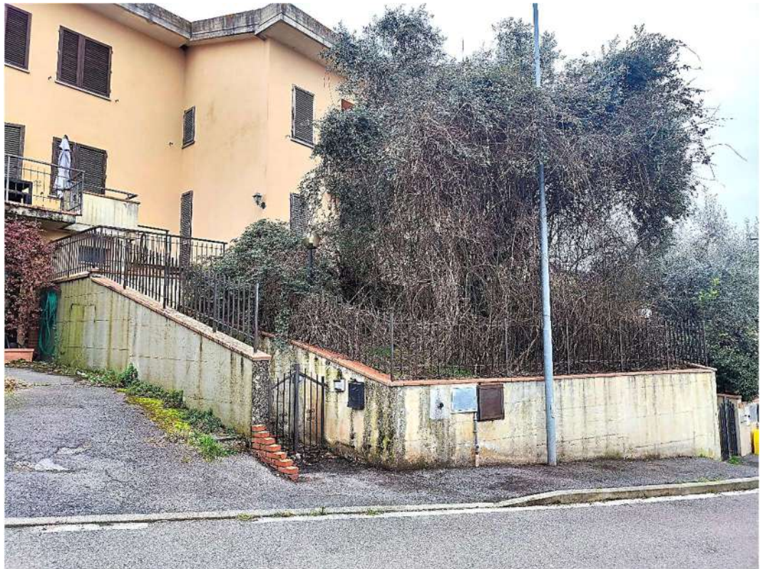
Foto 3 - La scala di accesso all'u.i. e il giardino visti da Via Salvador Allende
