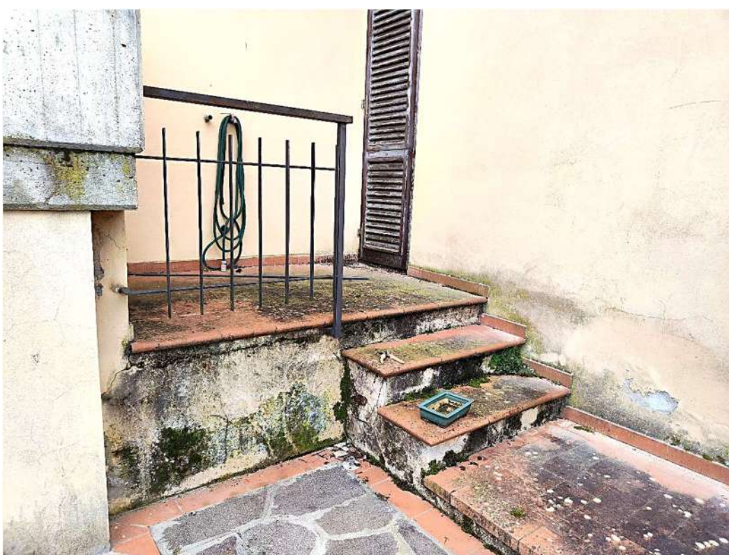
Foto 12 - Particolare delle terrazze del resede lato Via Salvador Allende
