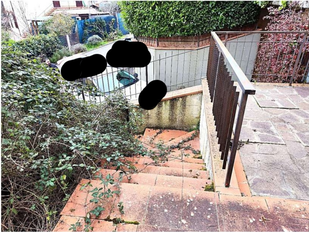
Foto 7 - La scala di accesso vista dal piano terra dell'abitazione
