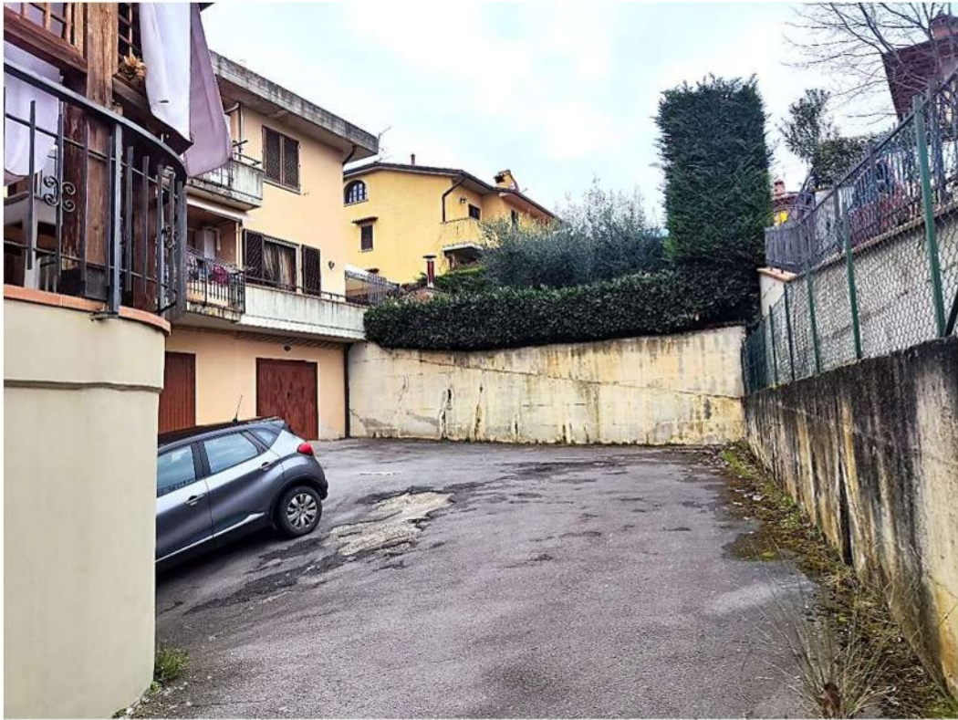
Foto 5 - La rampa di accesso al cortile carrabile comune (accesso al box auto)
