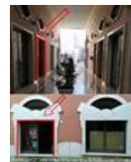
Riprese ingressi uii in androne principale e su traversa via Balsamo
