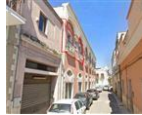
Foto scorcio fabbricato con individuazione unità Sub 29. Ripresa da Via B. Grimaldi
