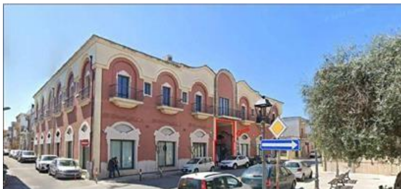
Foto d'insieme scorcio isolato fabbricato ed individuazione ingresso principale androne. Ripresa da Piazza Bartolo Longo
