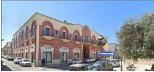
Foto d'insieme scorcio isolato fabbricato con individuazione ingresso principale androne. Ripresa da Pzza B. Longo
