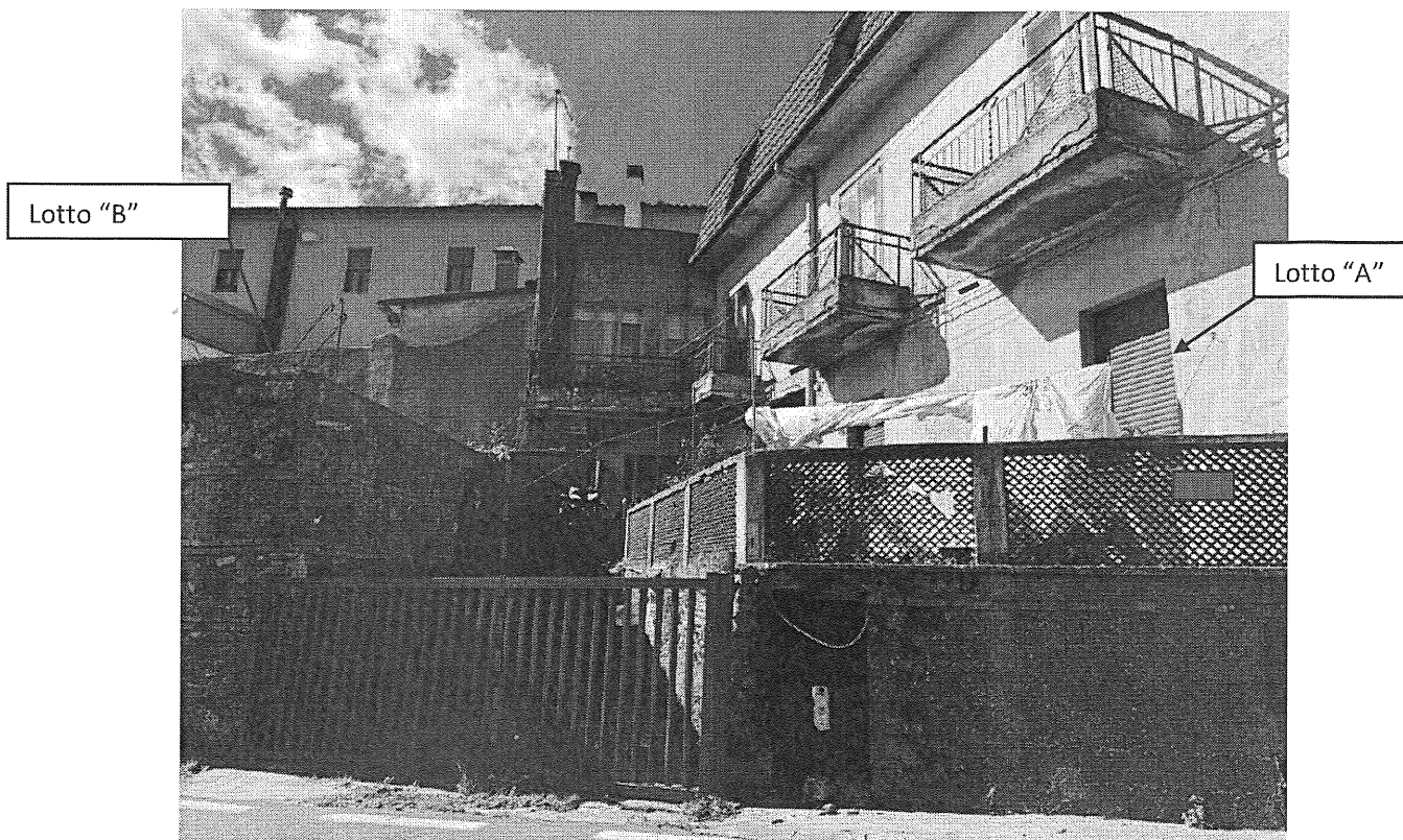
Foto 1 – Vista Immobili da Via Nazionale
