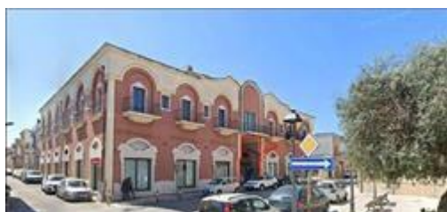
Foto d'insieme scorcio isolato fabbricato con individuazione ingresso principale androne. Ripresa da P.zza B. Longo
