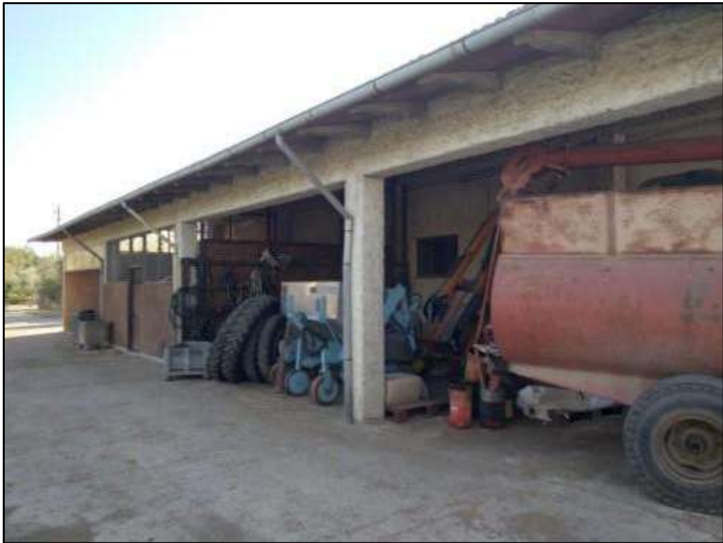
Foto 8 – tettoia lato est
