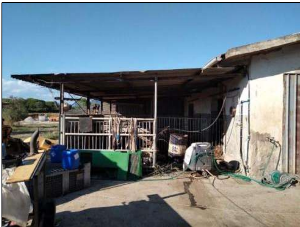
Foto 10 – tettoia lato ovest
