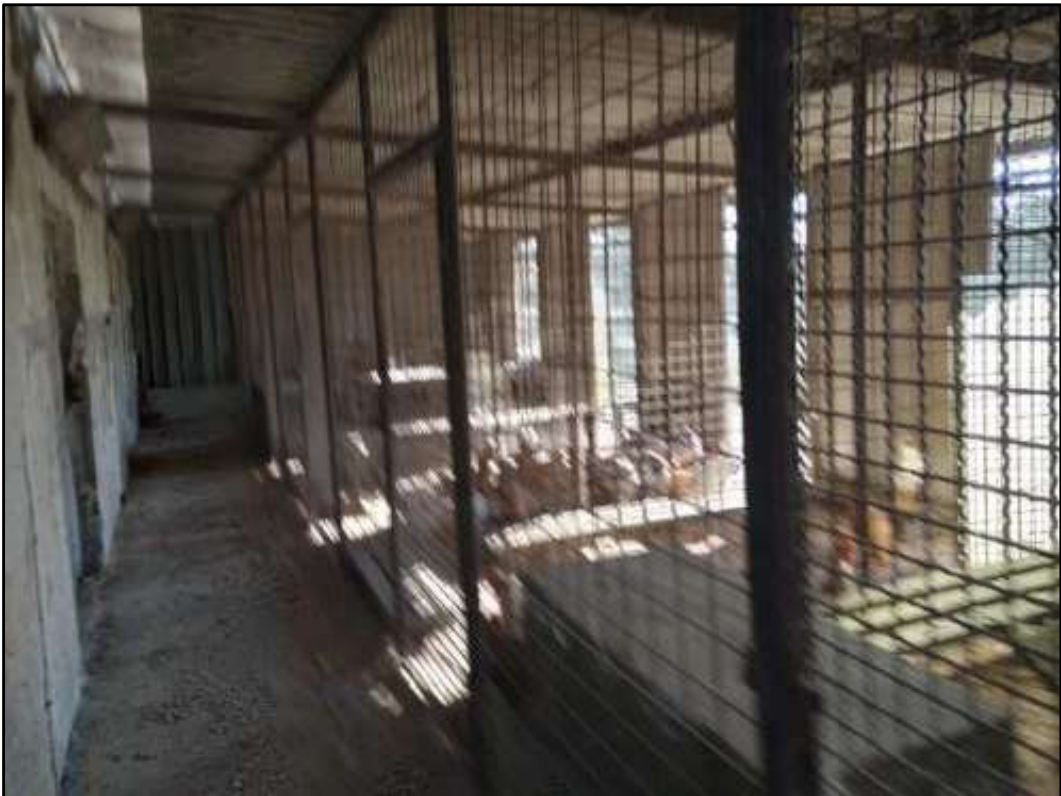
Foto 14 – tettoia lato ovest – interno
