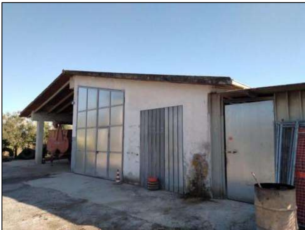
Foto 9 – fabbricato nord - prospetto
