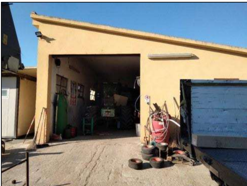
Foto 1 – fabbricato sud - prospetto
