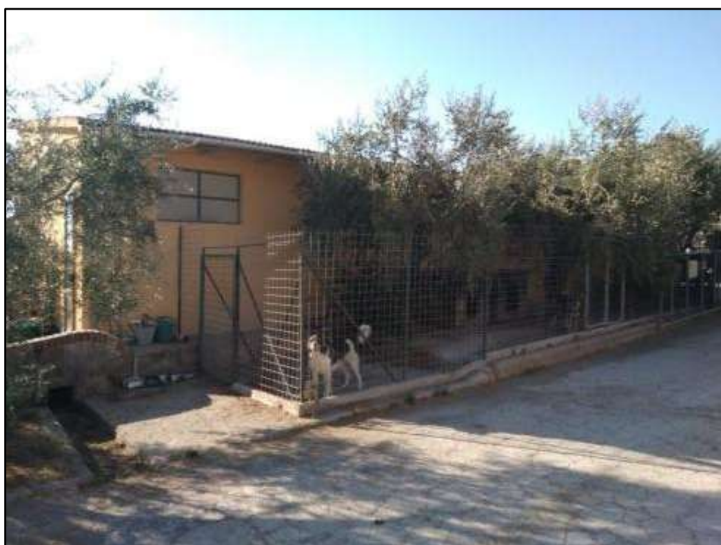
Foto 2 – fabbricato sud - prospetto
