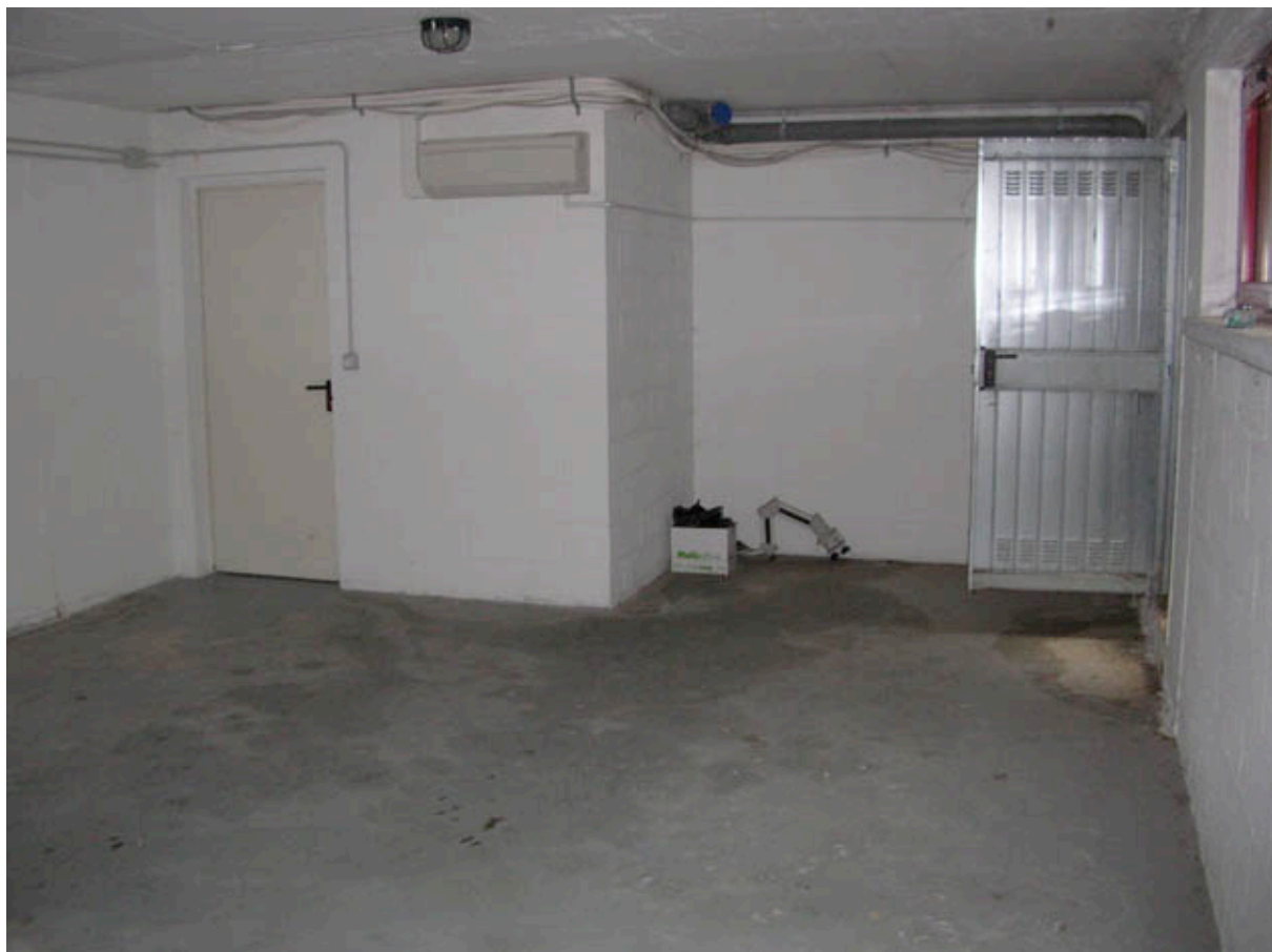
Il vano ad uso cantina sottostante
