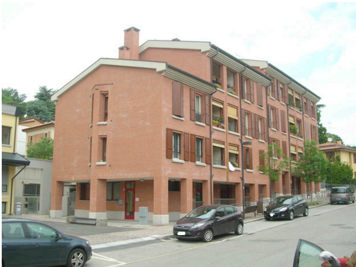
Prospetto fronte strada dell'edificio
