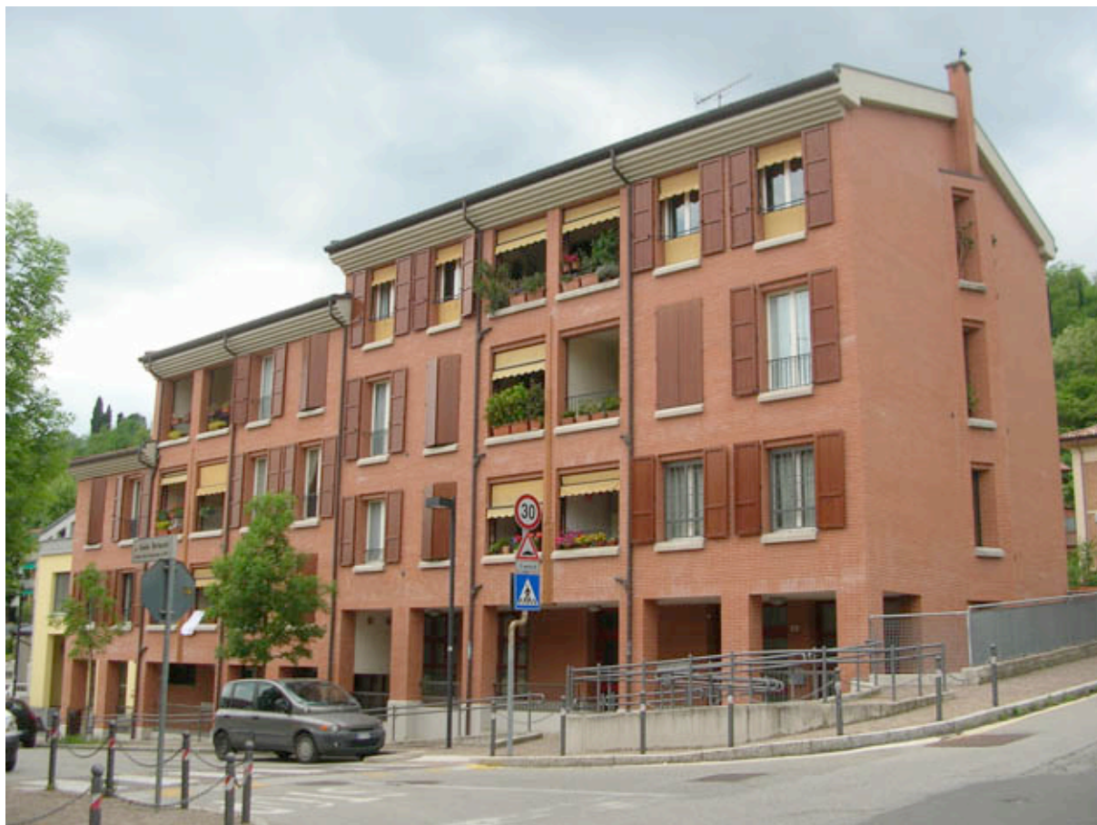
Prospetto fronte strada dell'edificio
