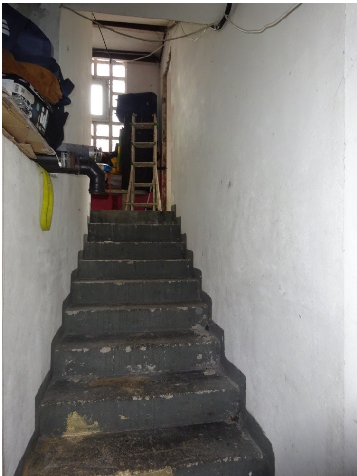
Locale refettorio al piano terreno del corpo di fabbrica ad ovest
