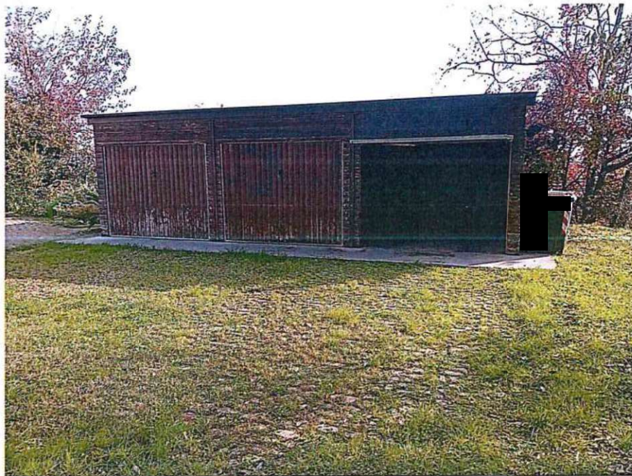
COSTRUZIONE ABUSIVA DA DEMOLIRE
