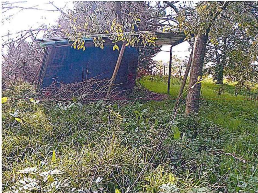
TETTOIA ABUSIVA DA DEMOLIRE
