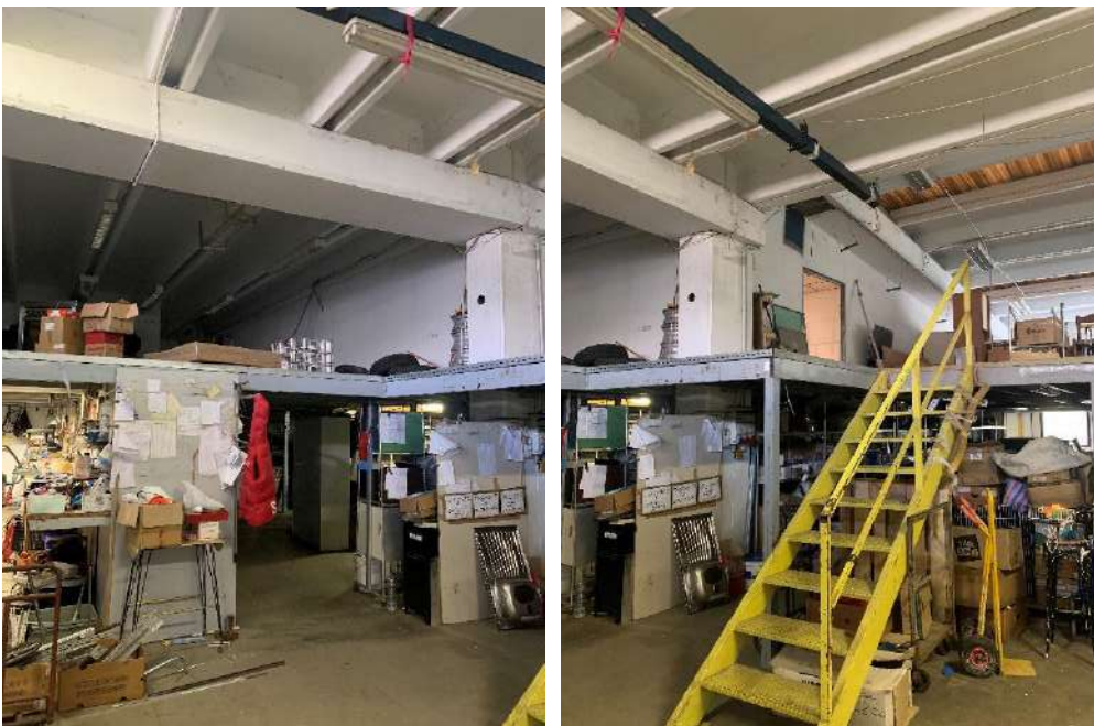
Foto 7 /Foto 8 – interno vista soppalco
