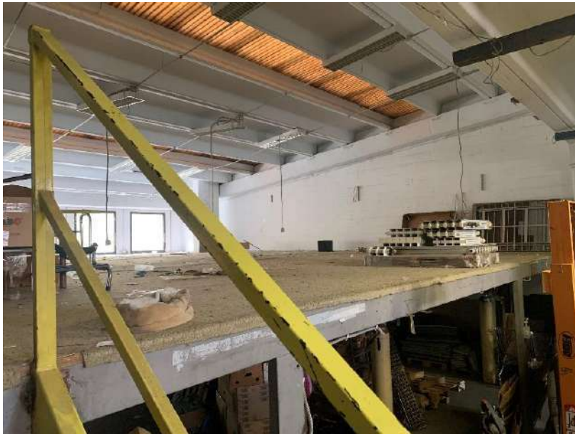
Foto 46 – vista PT e scala 1 di accesso a soppalco
