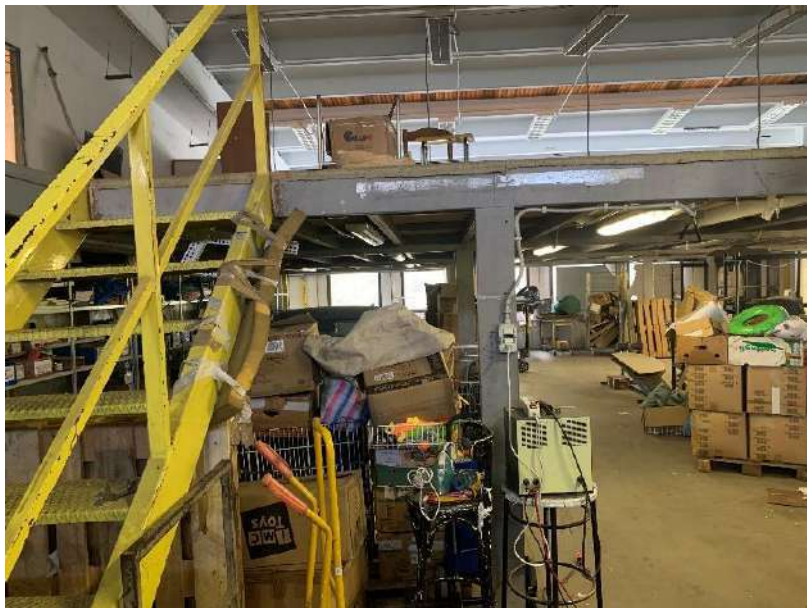
Foto 45 – vista PT e scala 1 di accesso a soppalco
