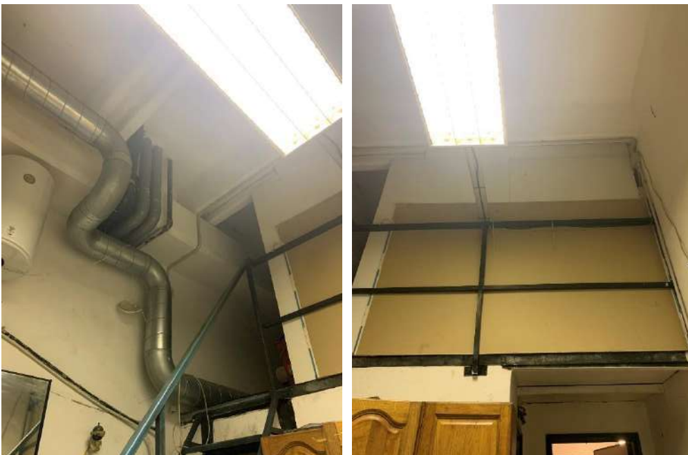
Foto 19 /Foto 20 – vista soppalco sopra locali bagno
