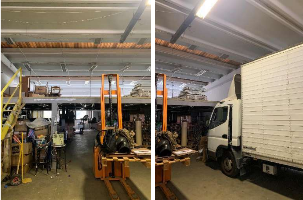
Foto 9 /Foto 10 – interno vista soppalco
