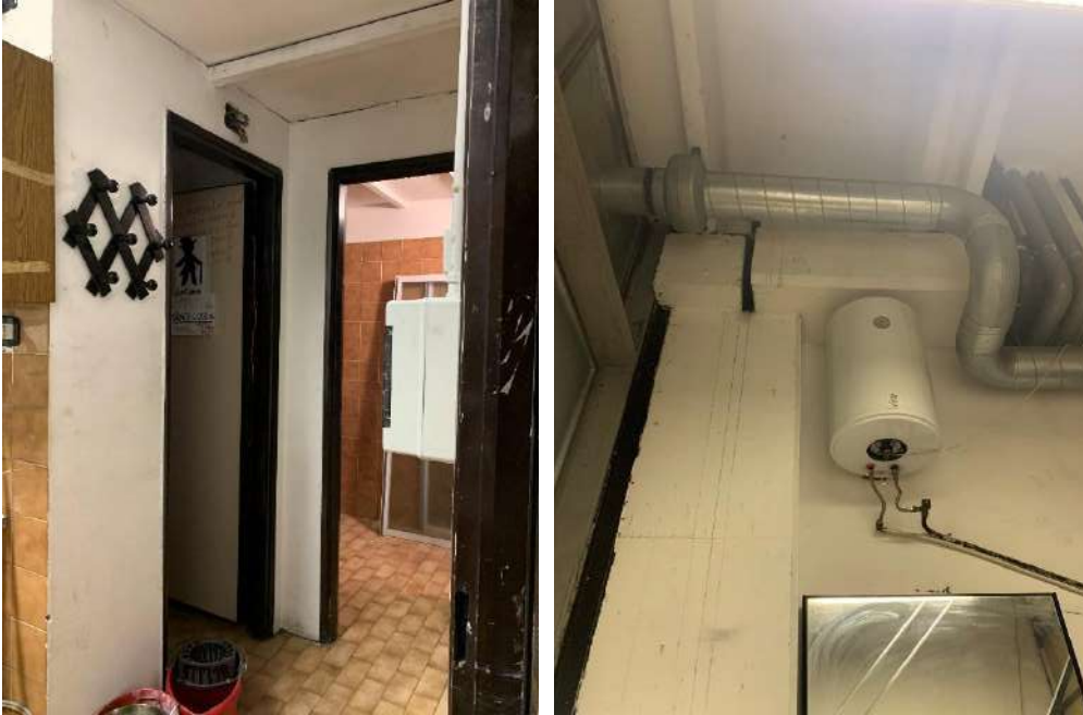
Foto 17 /Foto 18 – vista bagno sotto soppalco
