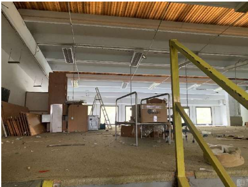
Foto 47 – vista soppalco da scala 1 di accesso
