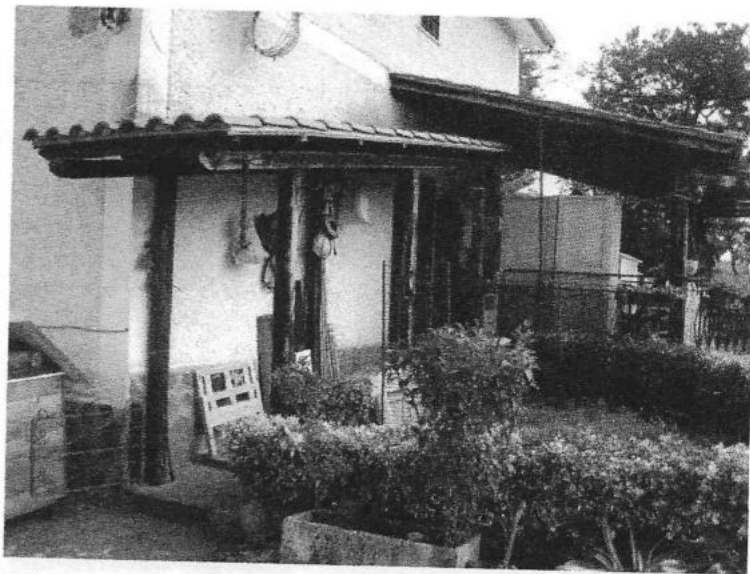
22 particolare della tettoia in legno sul lato sud
