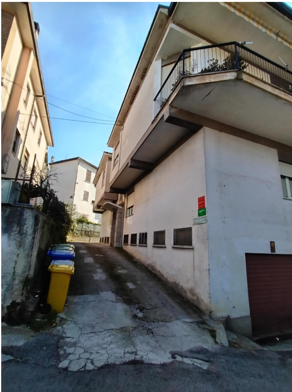
Foto 3 Rampa di accesso edificio
