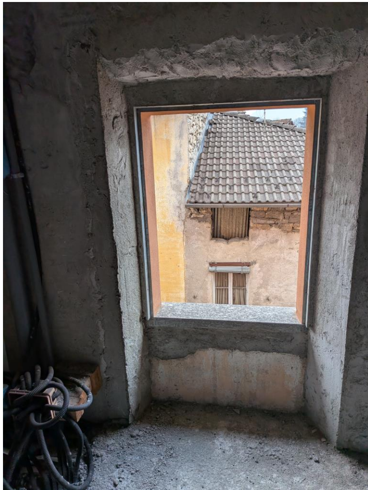
Foto 14 – locali secondo piano
