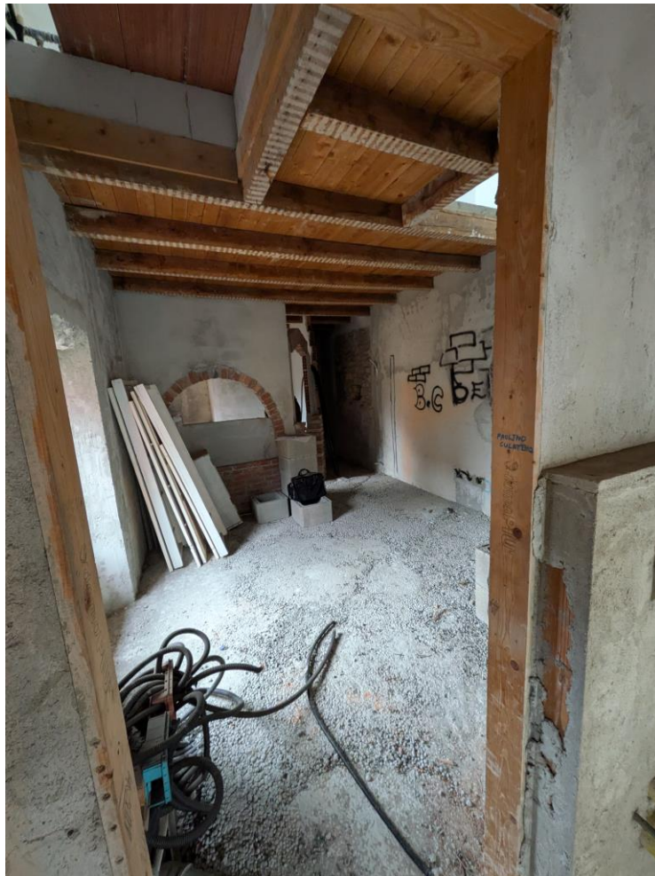
Foto 11 – locali secondo piano
