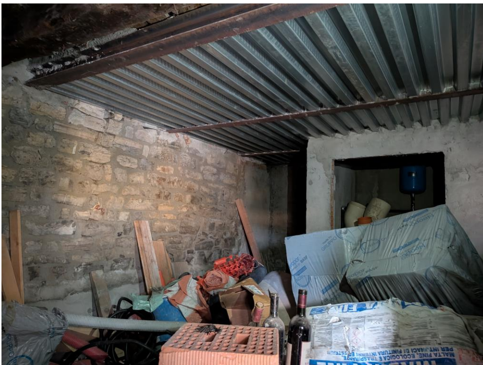
Foto 4 – locali piano seminterrato
