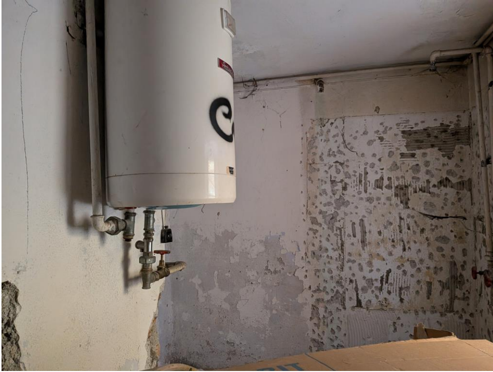
Foto 7 – locali primo terreno
