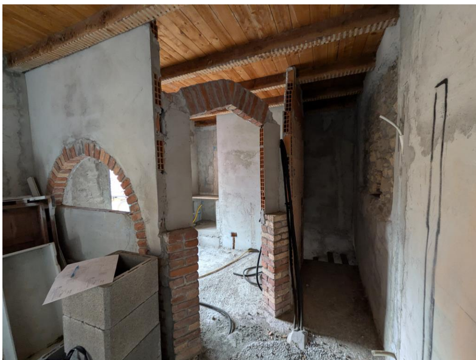
Foto 12 – locali secondo piano
