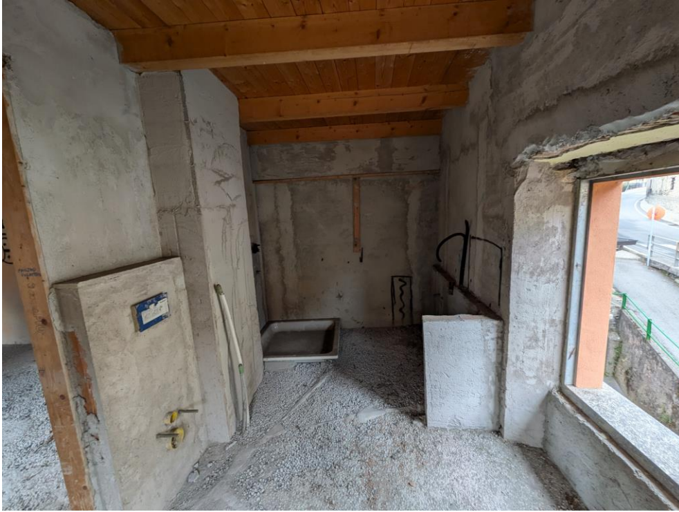
Foto 13 – locali secondo piano
