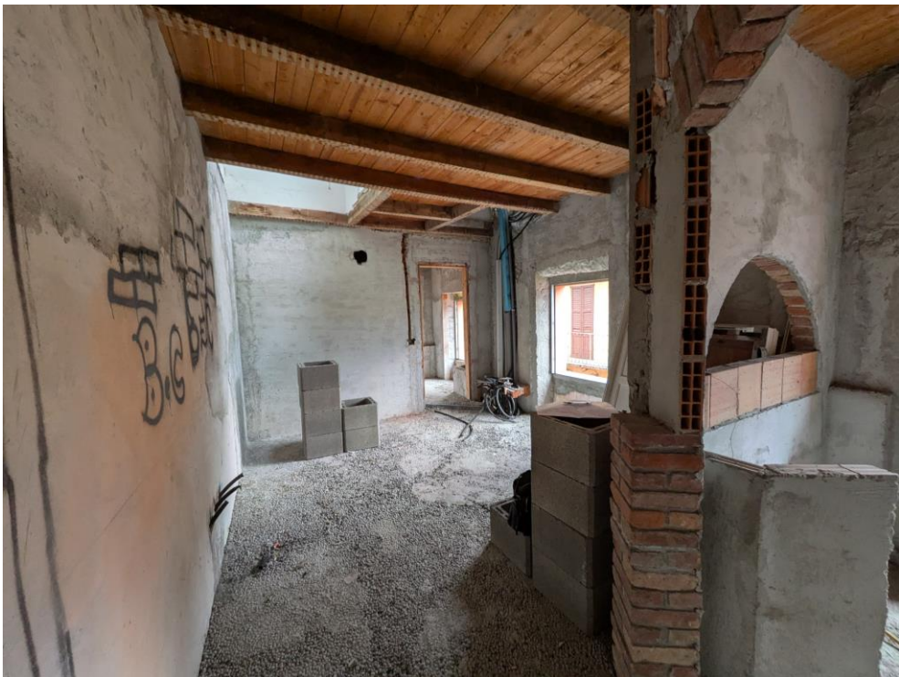
Foto 10 – locali secondo piano
