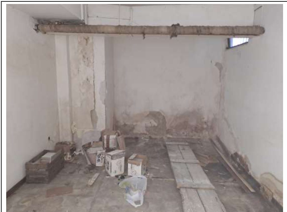
Foto n. 8 – Cantine / locali di deposito siti in Palermo, Via Palmerino n. 42, scala E, piano S1. Stato di fatto della cantina (sub 92)
