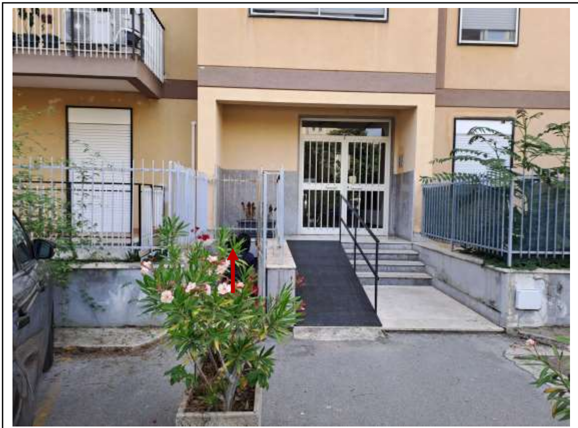
Foto n. 2 – Vista della zona ove sono ubicati il cancelletto e la rampa di scale di accesso alla cantina / locale di deposito sita in Via Palmerino n. 42, sc. E, piano S1
