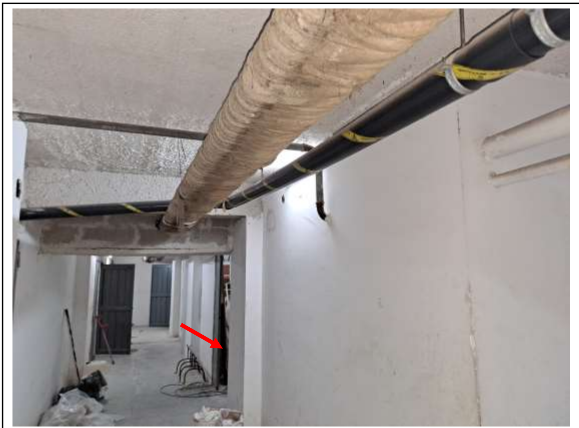
Foto n. 4 – Cantine / locali di deposito siti in Palermo, Via Palmerino n. 42, scala E, piano S1. Vista della porta di accesso ai sub 90, 91 e 92
