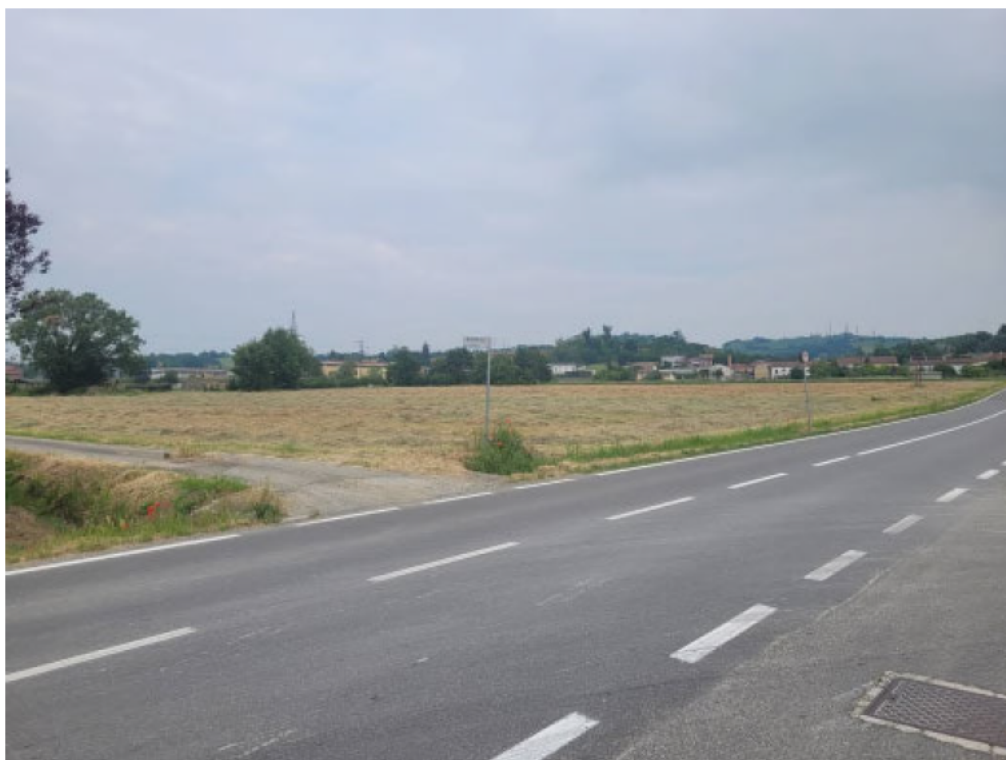
Foto 2 – vista a sud
