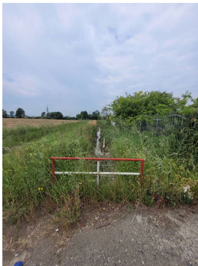
Foto 6 - vista di Canale Grattoni
