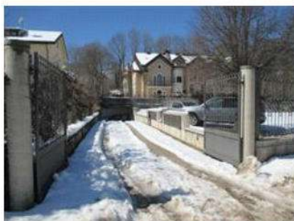
Vista esterna rampa di accesso da via Oppieto
