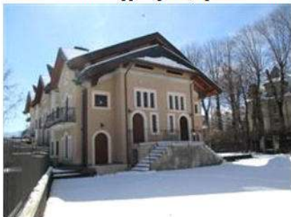
Vista generale dell'immobile
