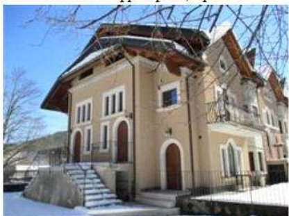
Vista generale immobile
