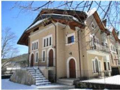
Vista esterna dell'immobile
