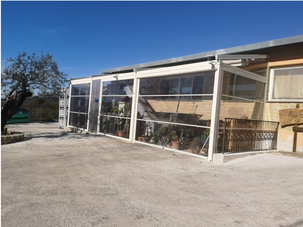
Foto n. 2 – Prospetto fabbricato Frantoio oleario - Corpo "A"
