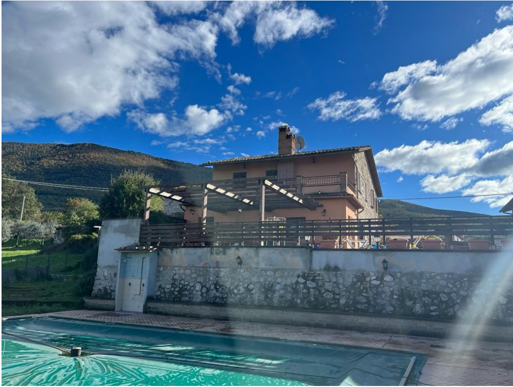
Foto n. 7 – Piscina - Corpo "A"
