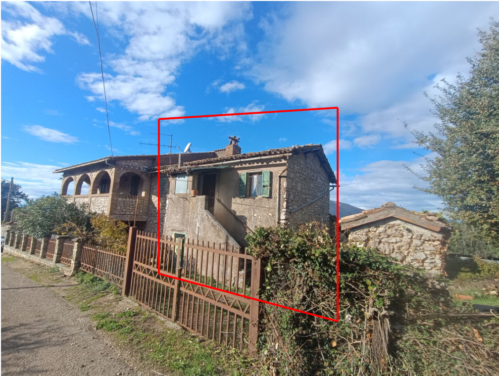
Foto n. 14 - Prospetto fabbricato principale - Corpo "D"
