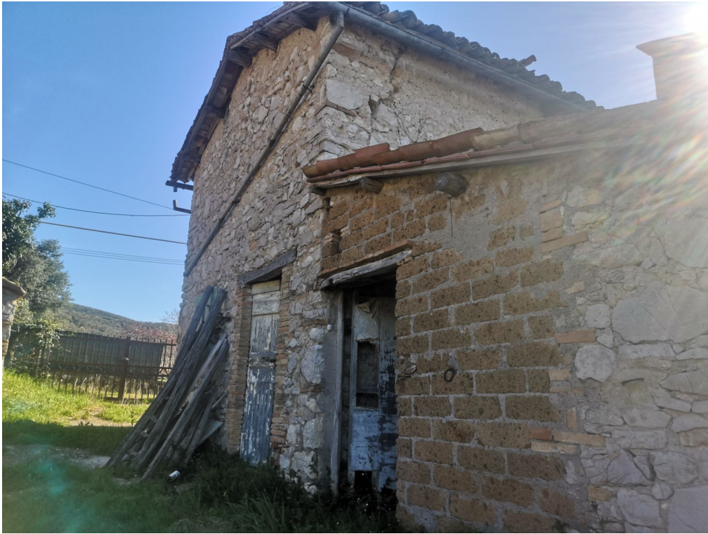
Foto n. 13 - Prospetto fabbricato principale - Corpo "D"
