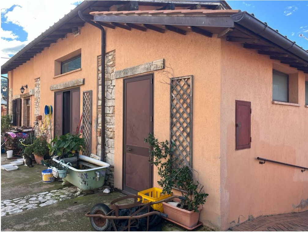
Foto n. 1 – Prospetto fabbricato Frantoio oleario - Corpo "A"
