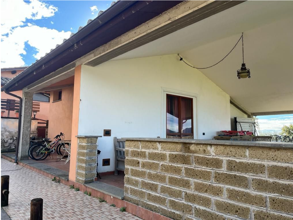
Foto n. 5 – Prospetto fabbricato Agriturismo - Corpo "A"
