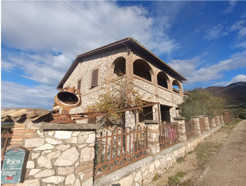
Foto n. 9 – Prospetto fabbricato - Corpo "B"
