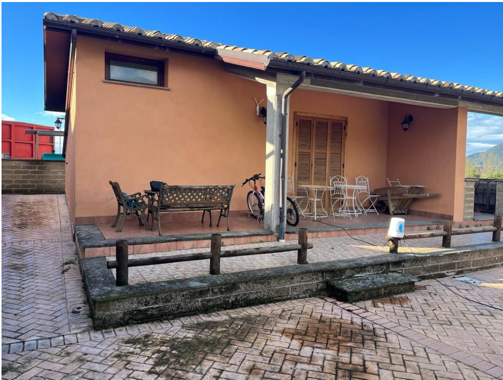
Foto n. 4 – Prospetto fabbricato Agriturismo - Corpo "A"
