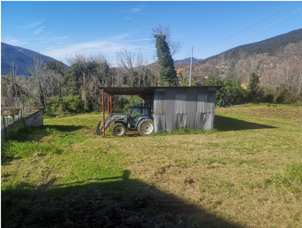
Foto n. 16 - Prospetto tettoia - Corpo "D"
