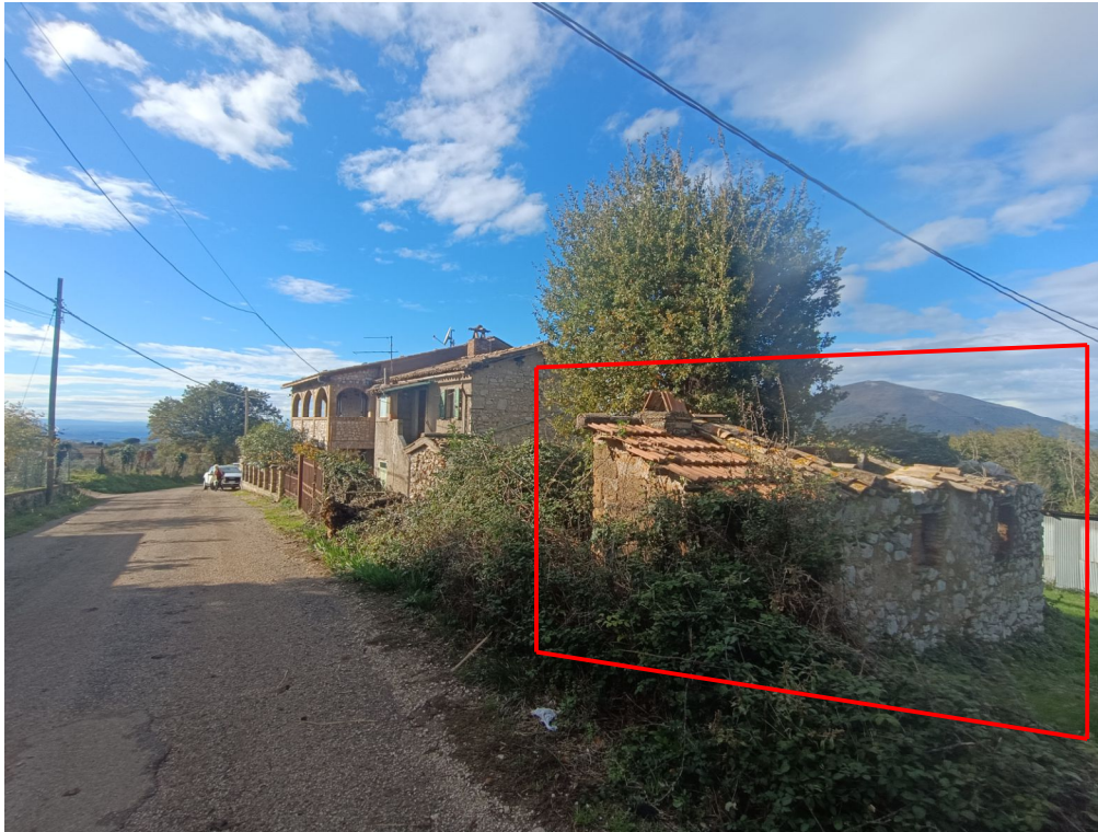
Foto n. 15 - Prospetto magazzino - Corpo "D"
