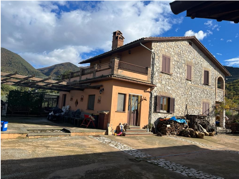
Foto n. 8 – Prospetto fabbricato - Corpo "B"
