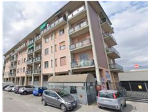
Particolare esterno edificio
