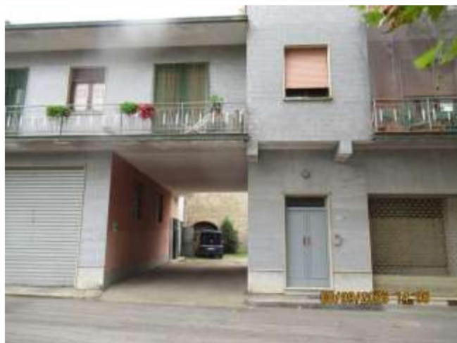
RIPRESA FOTOGRAFICA DELL'ANDRONE DA CUI SI ACCEDE E PROSEGUE NELL'AREA RETROSTANTE FINO A RAGGIUNGERE IL FABBRICATO OVE È SITUATA L'UNITÀ IMMOBILIARE.
