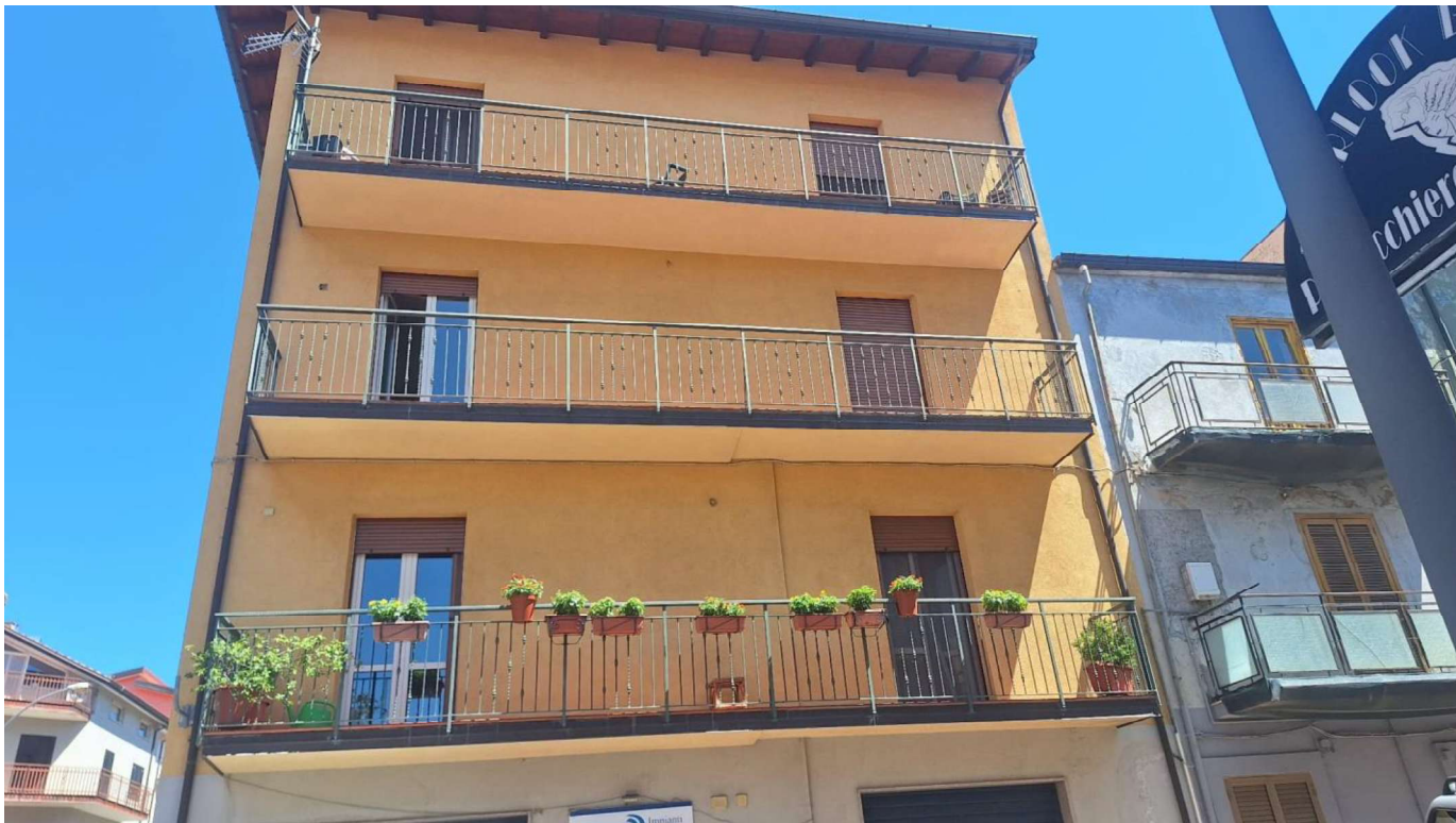
Foto n.3 – Particolare prospetto su via F. Gullo
