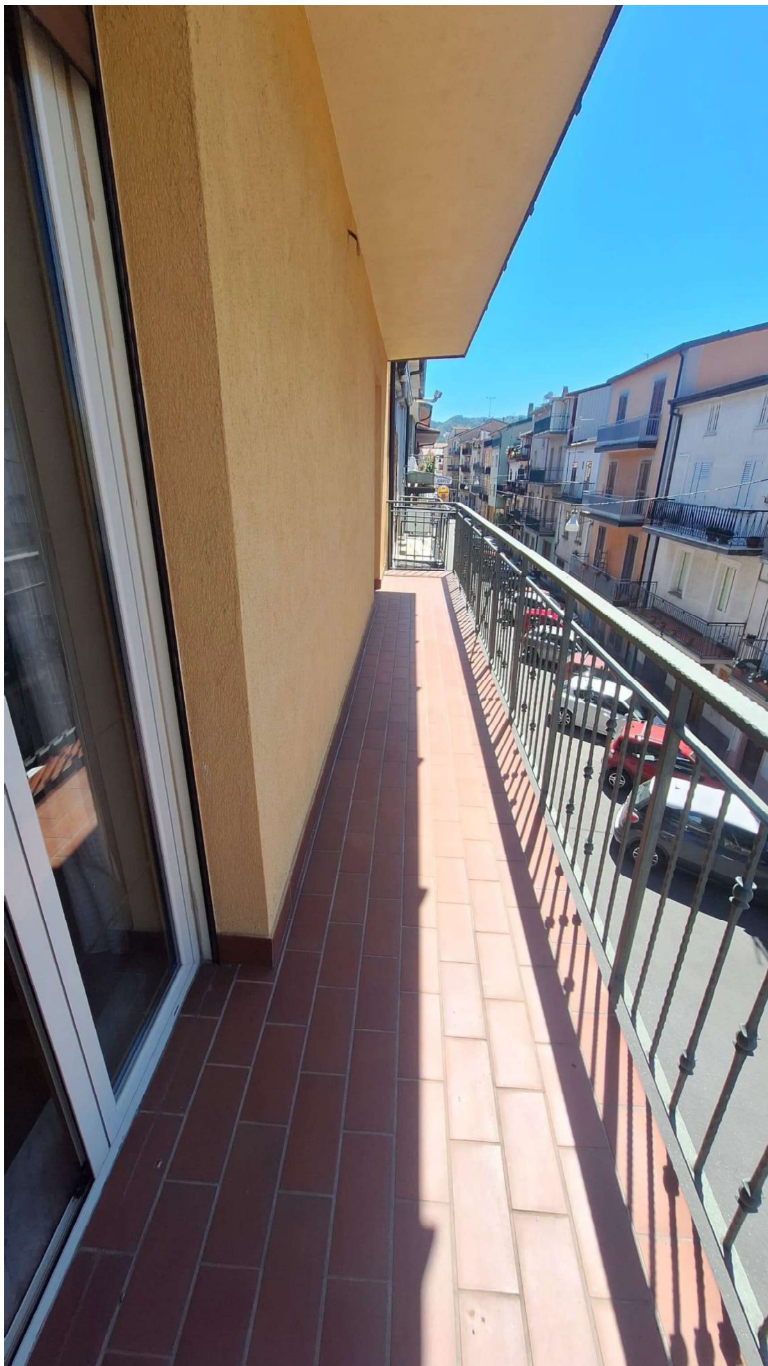
Foto n.15 – Balcone su via F. Gullo
