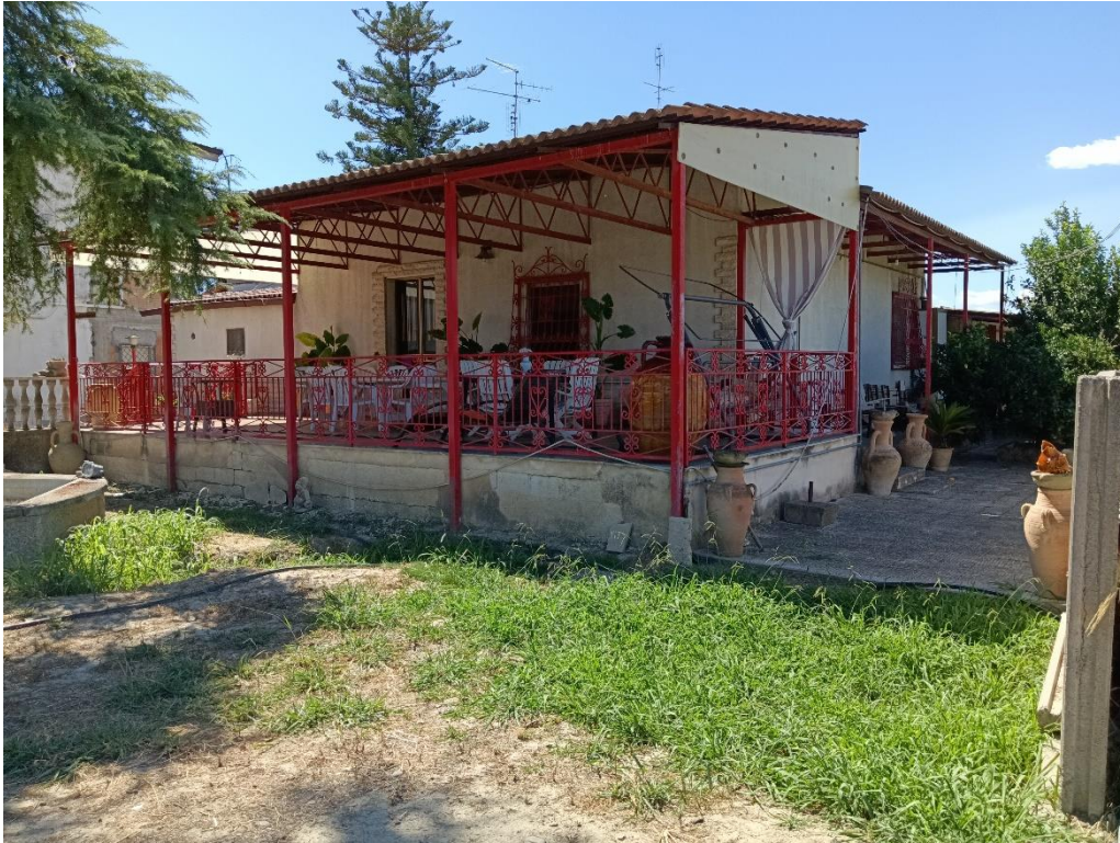
Foto n.7 – Vista Esterna- prospetti N/E-N/O- Area esterna interna al perimetro recintato Tettoia su terrazzo e su camminamento
