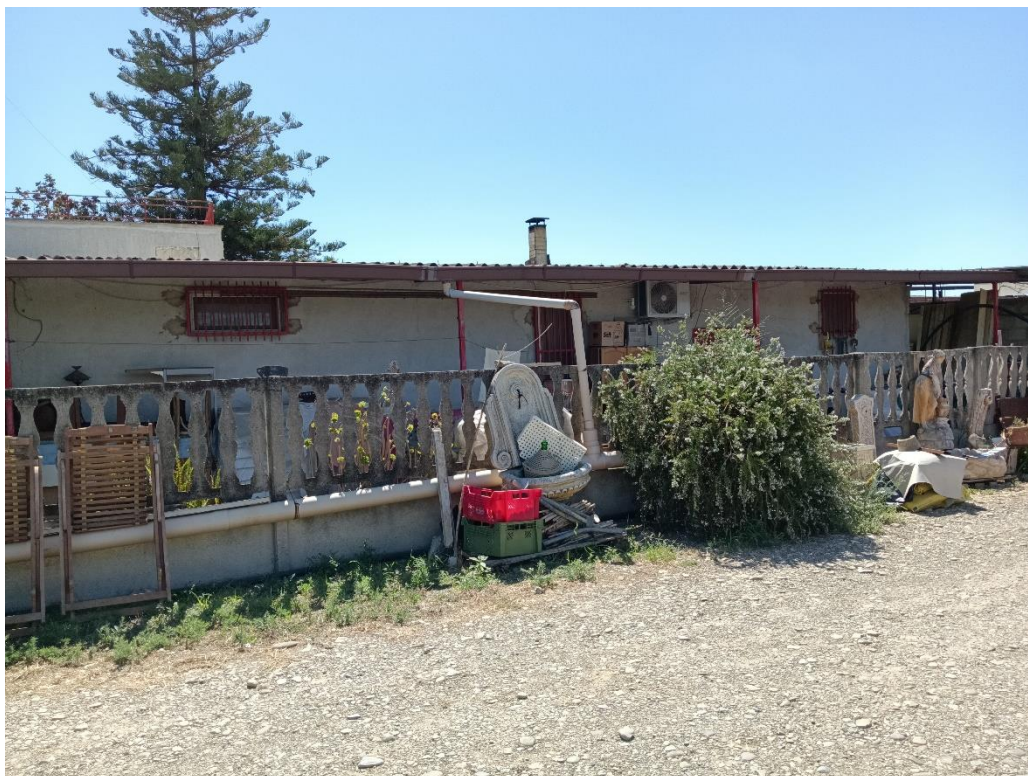
Foto n.8 – Vista Esterna- prospetto N/O- camminamento- recinzione con parapetto
