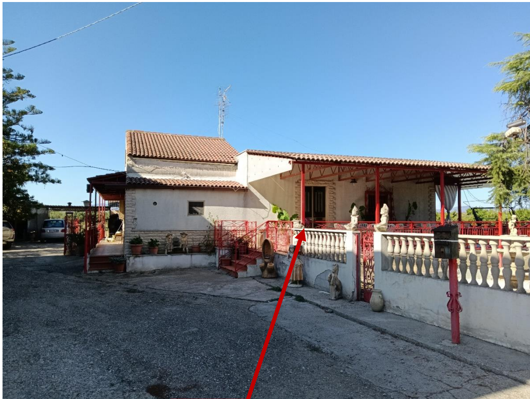
Foto n.1 – Vista Esterna- Ingresso 2 , Accesso dalla strada comunale Viale del Lido n.12
