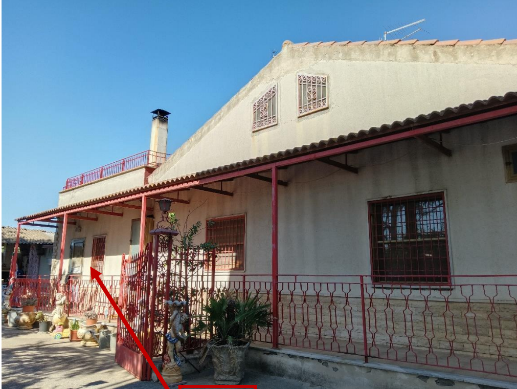
Foto n.9 – Vista Esterna- Ingresso 3- prospetto S/E- tettoia su camminamento
