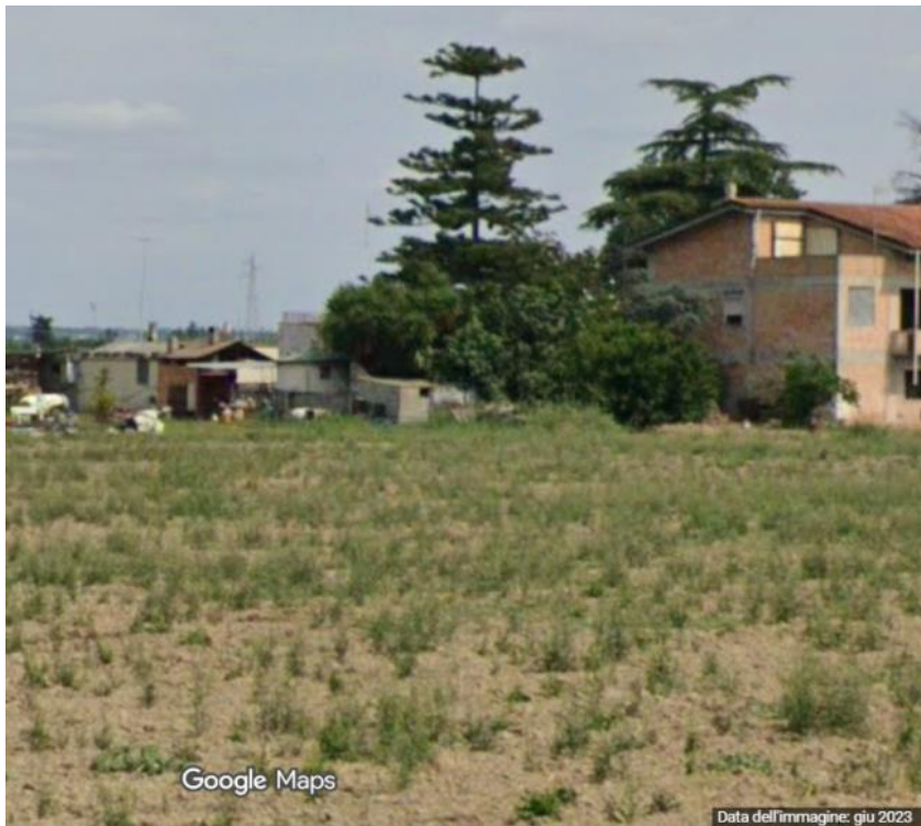
google maps 2023 vista prospetto retro-tettoia
