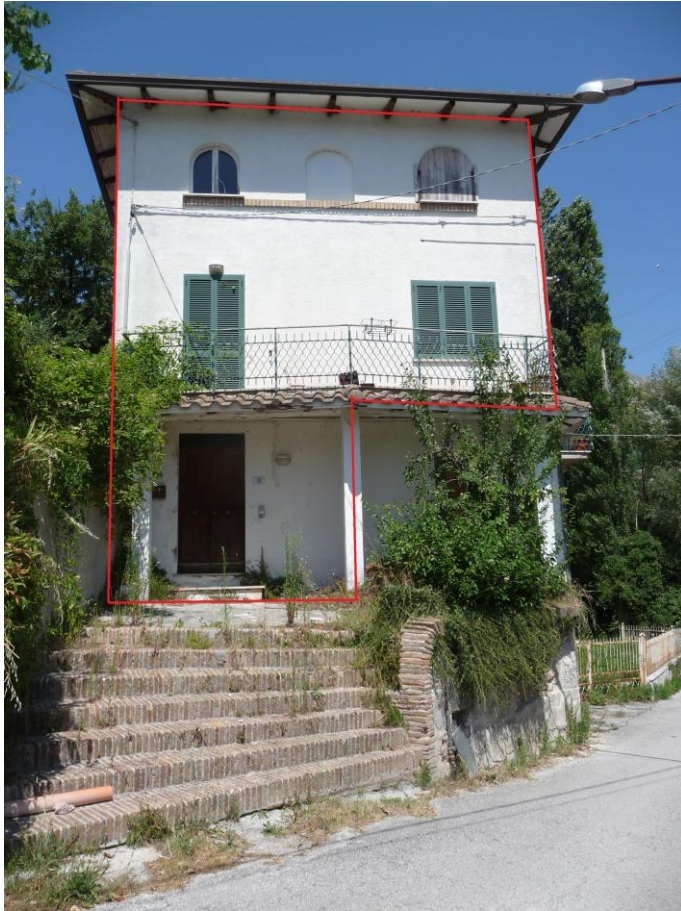
Ingresso da via Buia (civico 29)
