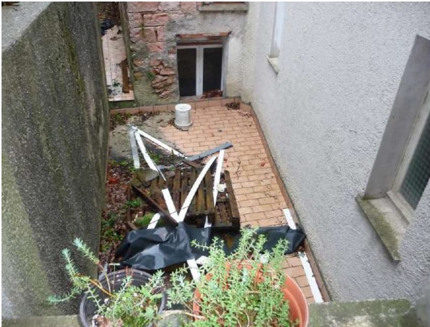
Foto n. 15 Terrazza retro edificio
