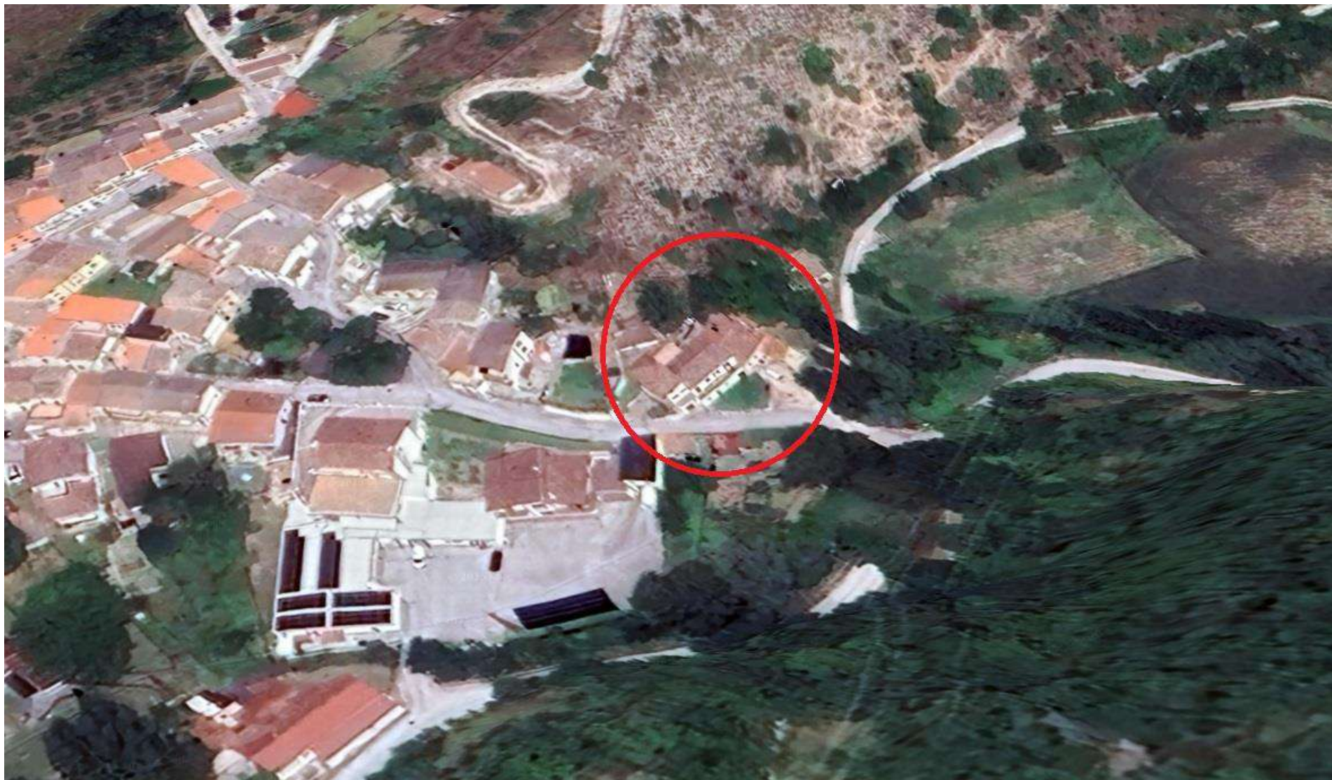
Foto n. 1 Vista aerea (da google earth)
