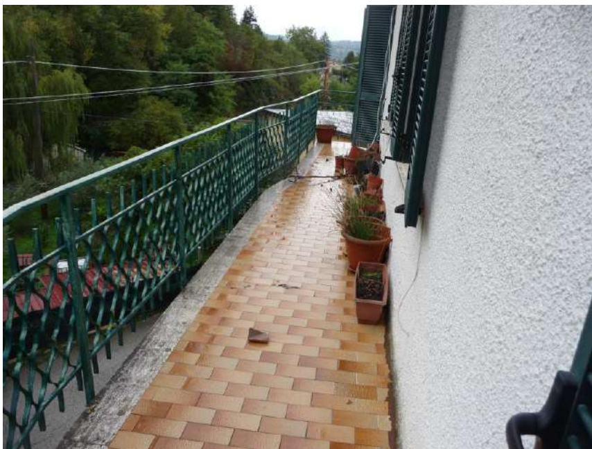
Foto n. 13 Balcone fianco edificio P1
