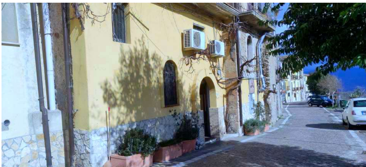
Foto 21 - Esterno fabbricato, ingresso ristorante, vista da SO
