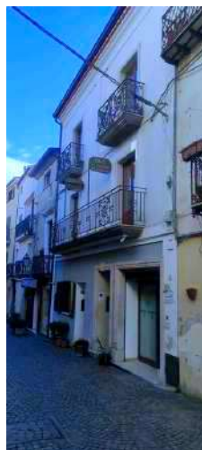
Fronte fabbricato p.lla 238, lato nord su c.so Mazzini
