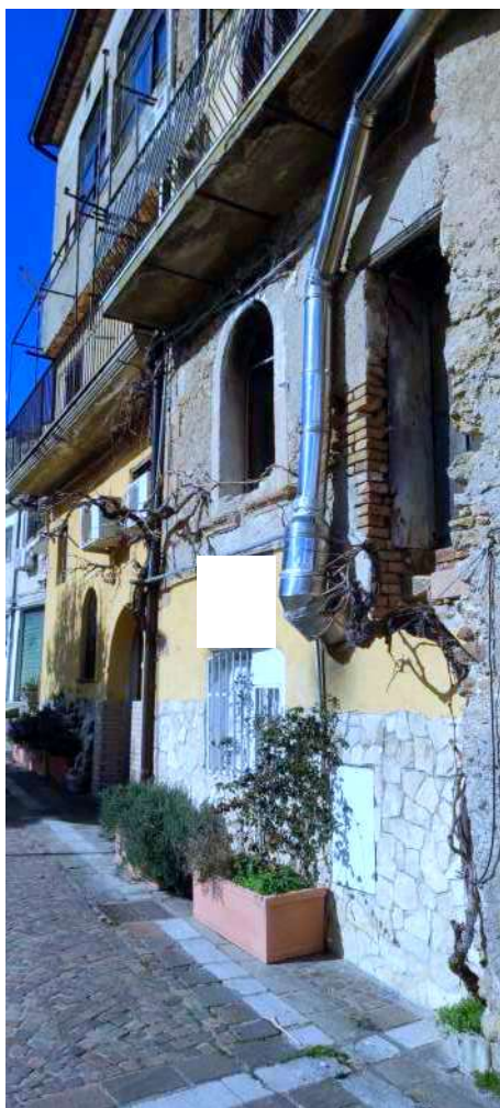
Foto 22 - Esterno fabbricato, vista da SE
