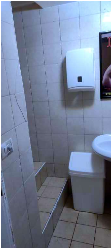
Foto 5 - ingresso w.c. donne
