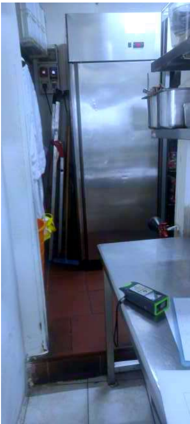
Foto 18 - cucina : vista dispensa/spogliatoio
