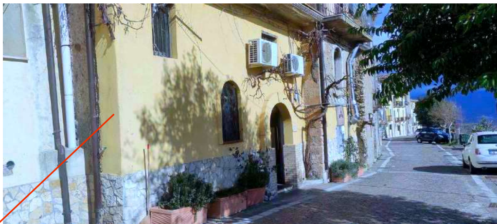
Fronte fabbricato p.lla 238, lato sud su via Bellarintha : unità immobiliare al P.T. (ristorante)
