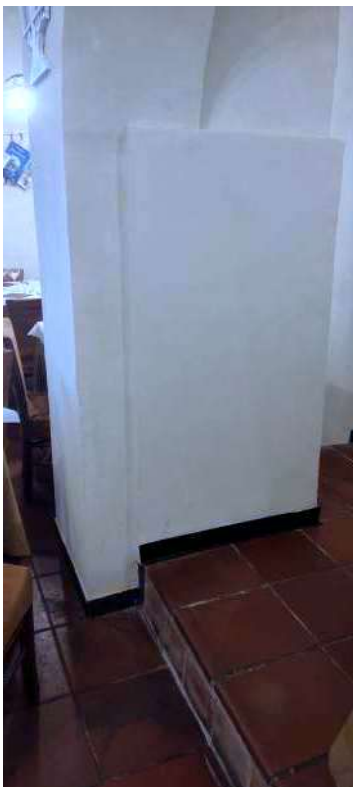
Foto 11 - sala ristorante, dettaglio colonna/dislivello
