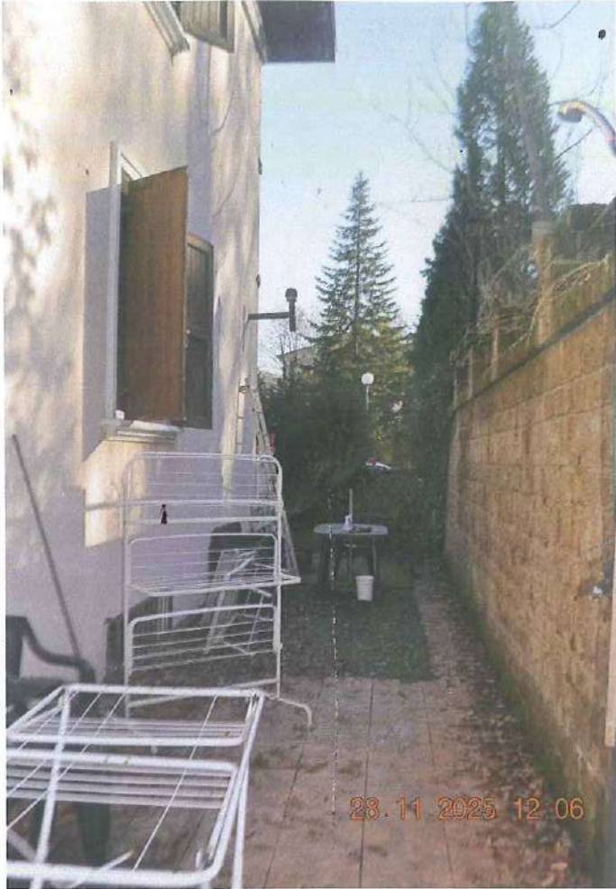
PROSPETTO SUD FOTO 1
