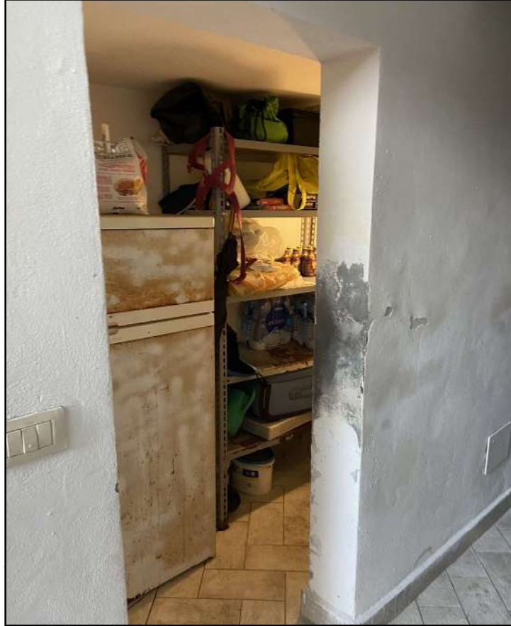
ripostiglio sottoscala - PT
