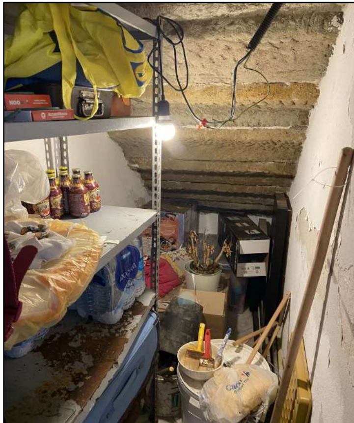
ripostiglio sottoscala - PT
