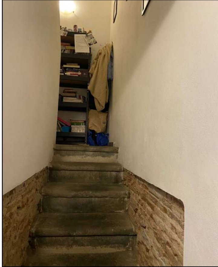
scala di accesso al P1
