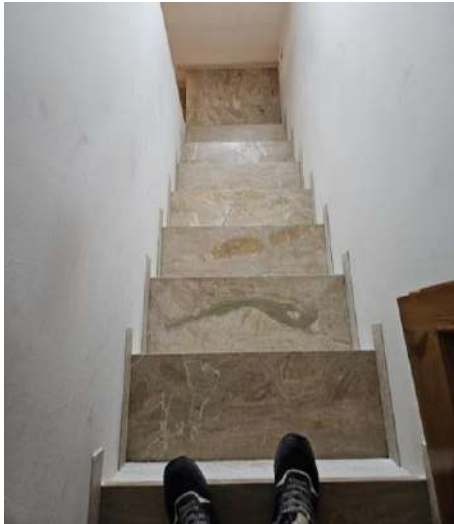
FOTO 11: vista vano scala
