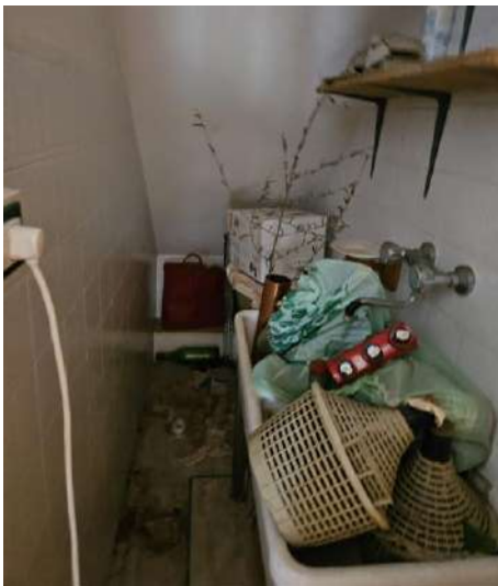
FOTO 18: vista ripostiglio sottoscala
