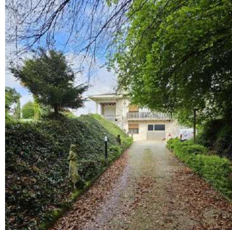
FOTO 2: vista prospetto sud
