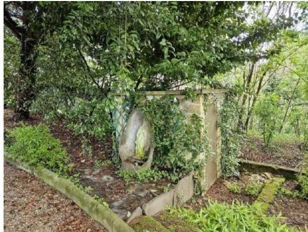
FOTO 3: vista vano tecnico
