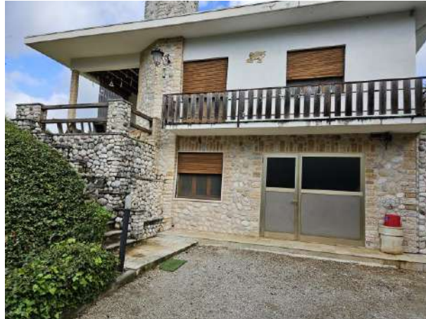
FOTO 4: vista prospetto sud
