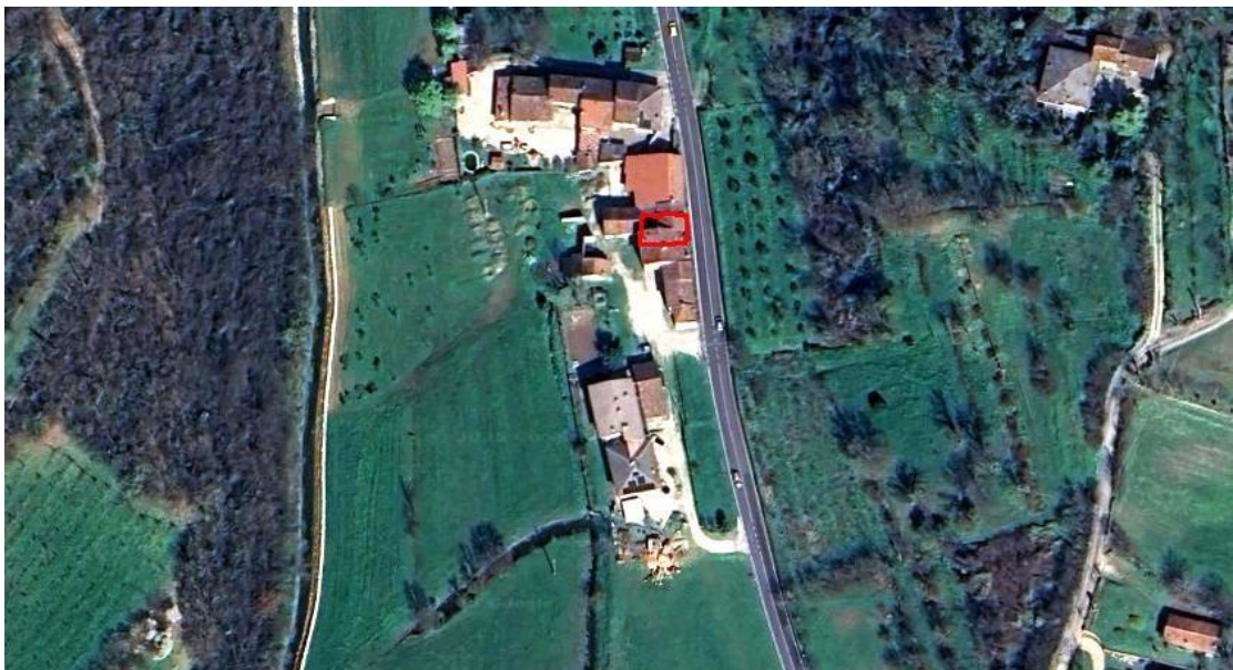
Vista da Google Maps
