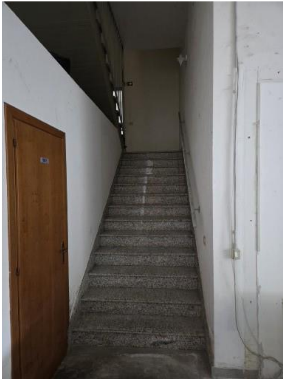
Foto 14 – Scala di accesso al piano primo
